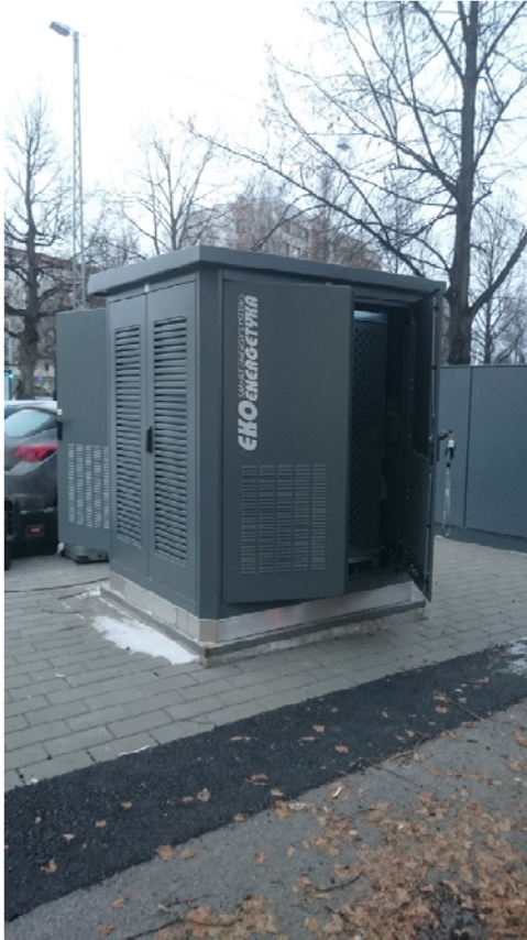
Kuva 4. Pyynikintorin pikalatauslaite ja sen vaatima infrastruktuuri
