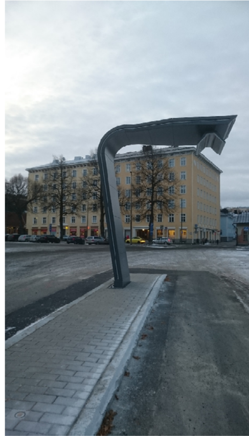
Kuva 4. Pyynikintorin pikalatauslaite ja sen vaatima infrastruktuuri
