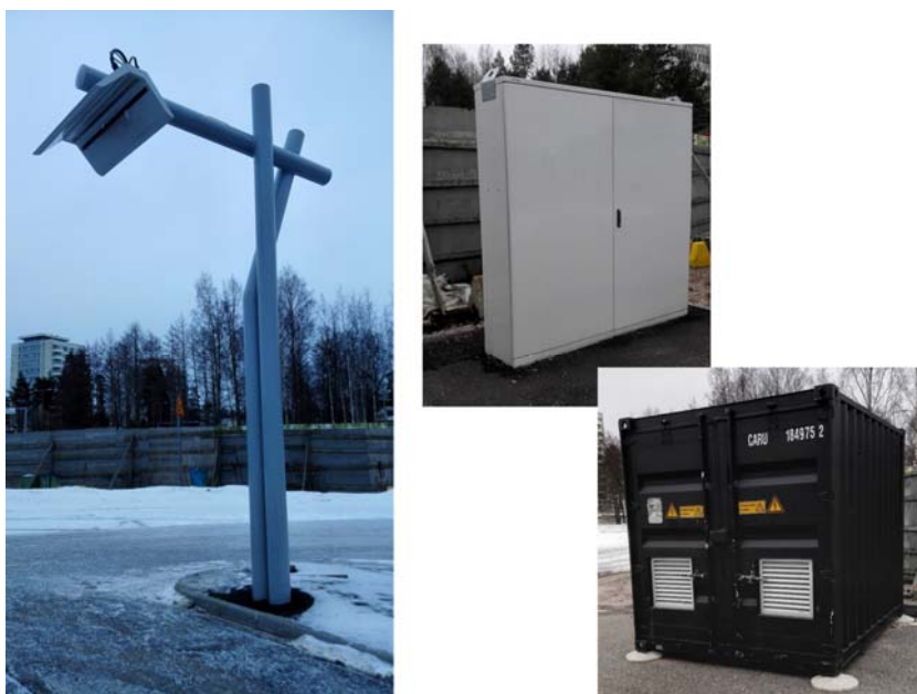
Kuva 1. Tapiolan pikalatauslaite ja sen vaatima infrastruktuuri
