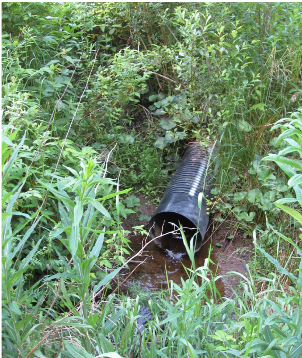
Kuva 10. Salaojien purkuputkien korkeudet tulee ottaa huomioon kosteikkaa suunniteltaessa, ettei lähipellon kuivatukselle aiheudu haittaa. Kuva: Hanna Eskola
