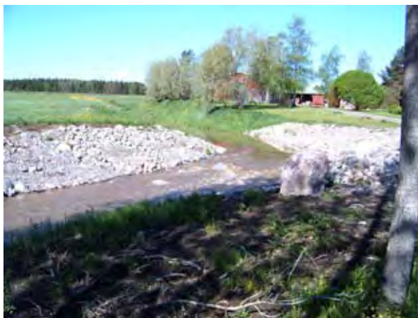
Kuva 18. Aholan pohjakynnys valmiina.
