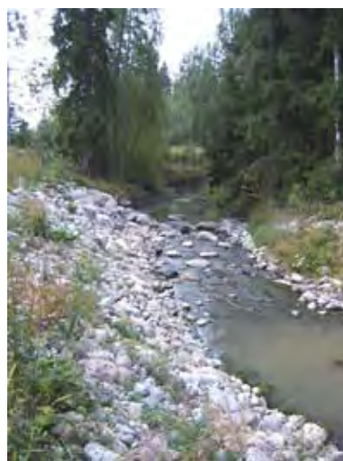
Kuva 20. Vikströmin pohjakynnys valmiina.
