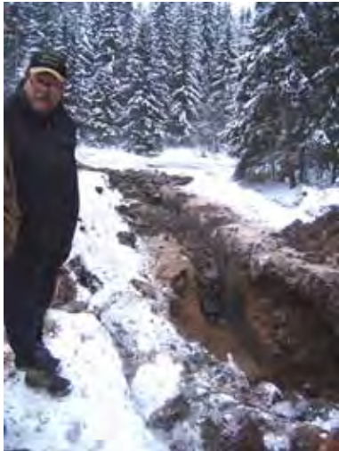
Kuva 26. Ruhalan ojan putkitustyötä ojasortuman viereen. Kuvassa ympäristötyönjohtaja Pertti Ruukonen.
