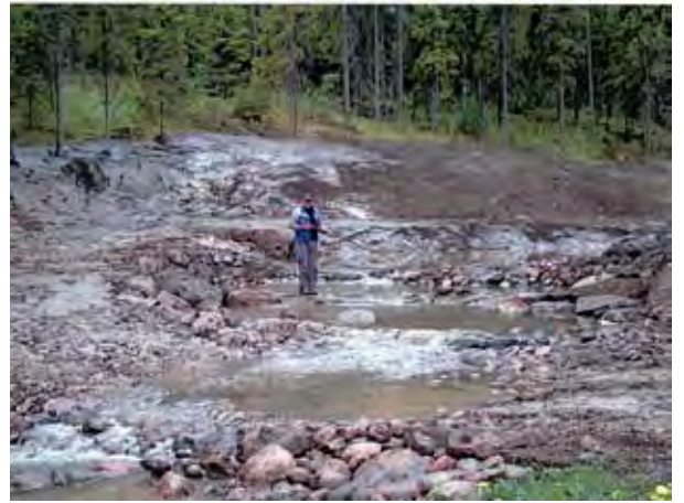
Kuva 12. Palosen pohjakynnyksen ja koskiosuus juuri muotoiltuna kesällä 2004.
