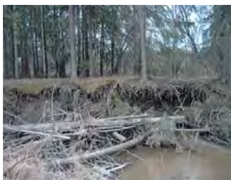
Kuva 29. Köylinjoen uomaa Köylisen eroosiokorjauksen kohdalla ennen.
