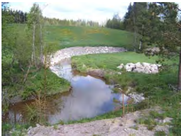
Kuva 35. Tupaselan eroosiokorjausta Köylinjoen mutkassa.
