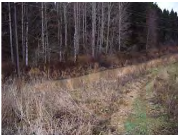
Kuva 44. Sipilän pohjakynnyksen paikka ennen rakennustöitä.
