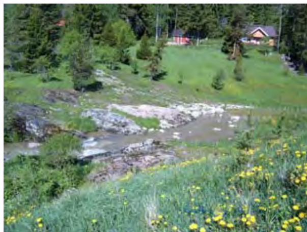
Kuva 14. Litinkosken pohjakynnyks valmiina kesäaikana.
