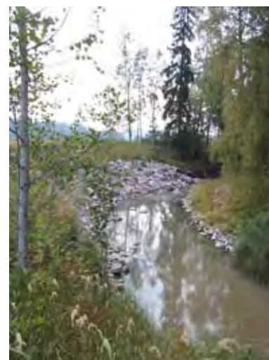
Kuva 21. Vikströmin pohjakynnys valmiina.
