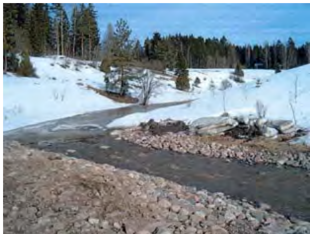
Kuva 13. Litinkosken pohjakynnyks valmiina.
