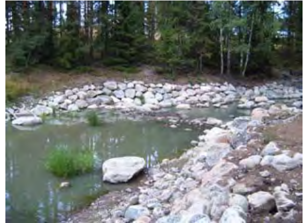
Kuva 49. Ylä-Myllykosken pohjakynnys alivesiaikana kesällä 2006.
