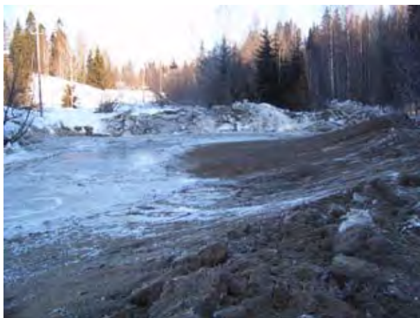
Kuva 36. Tupaselan tulvatasanne kaivettuna.
