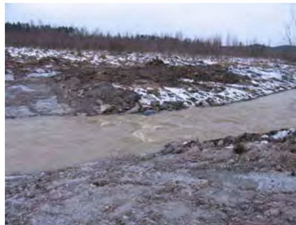
Kuva 55. Mäkelän pohjakynnyksen valmiina tulva-aikana joulukuussa 2006. Keskellä matalampi ylityspaikka (alla).
