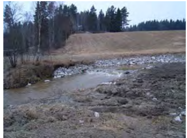
Kuva 41. Tupaselan pohjakynnyksen valmiina.
