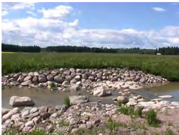
Kuva 43. Vainion pohjakynnys valmiina kesällä 2006.
