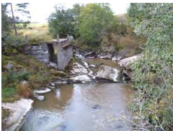
Kuva 33. Sammalkoski ennen kunnostustoita.
