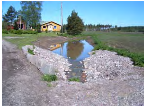
Kuva 16. Pitäänojan laskeutusallas valmiina.
