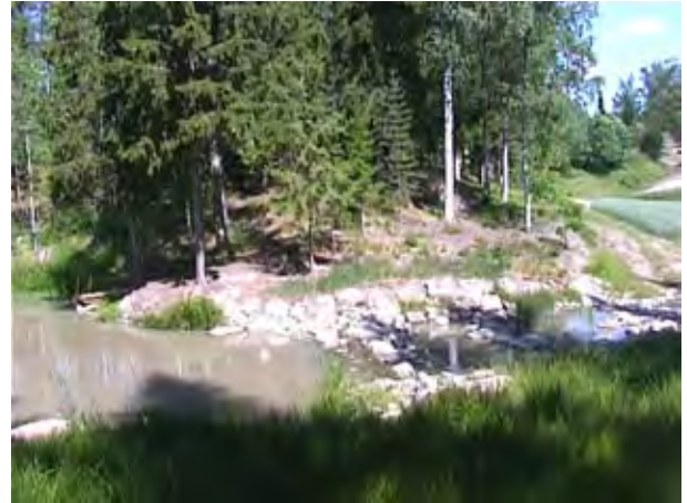
Kuva 10. Palosen pohjakynnyksen kunnostustöiden jälkeen.
