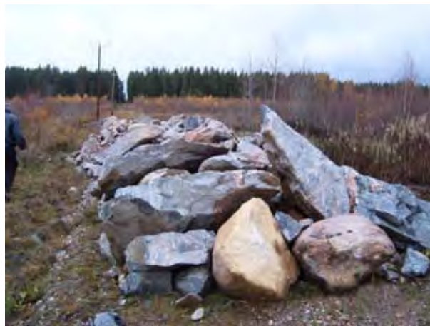
Kuva 53. Mäkelän pohjakynnyksen tekoa varten ajettua ajettua louhetta työmaatiellä.
