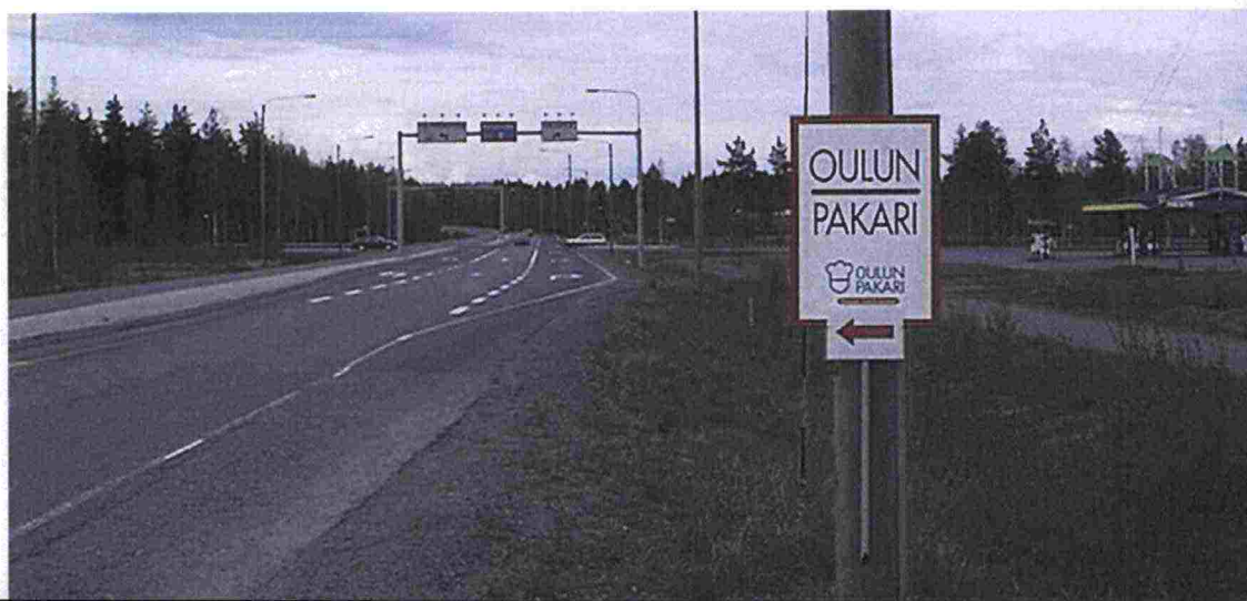
Kuva 18. Valaisinpylvääseen kiinnitetty mainos, joka sekoittaa liittymän virallista opastusta.
