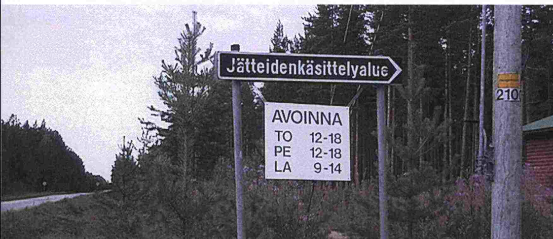
Kuva 19. Opastusviitan ja mainoksen yhdistelmä, joka on käsikirjan vastainen.
