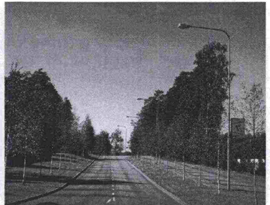
2) Tievalaistus. Metallipylväät ja maakaapeli
