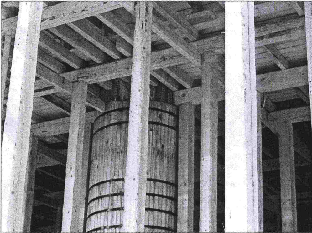
Kuva 15: Niskojen kiilaus pilaria vasten Marjamäen sillassa
