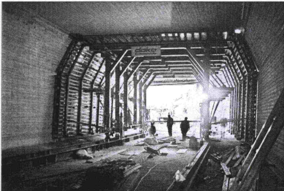
Kuva 44: Siirtoradalla vaiheittain etenevä tunnelimuotti
