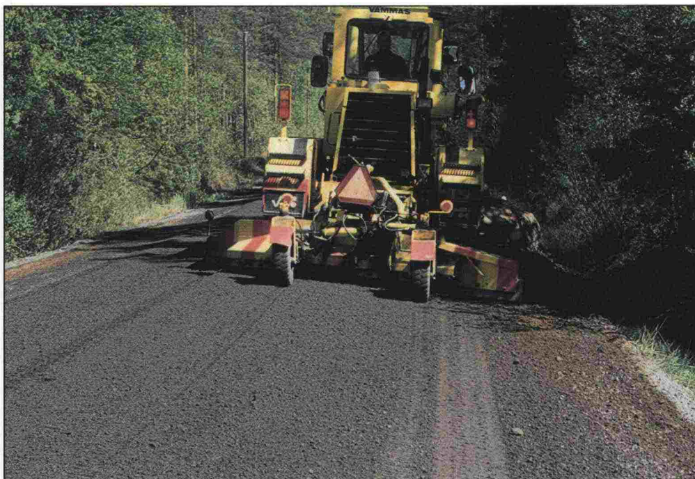
Kuva 4c. Tien keskellä oleva materiaali levitetään keskiviivan molemmille puolille. Lopuksi materiaali tasoitetaan kummallekin ajokaistalle.
