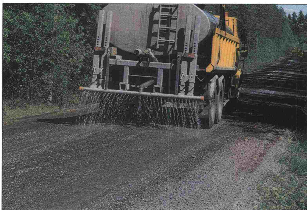
Kuva 7c. Tarvittaessa tie kastellaan, jotta suola liukenee paremmin kulutuskerrokseen.
