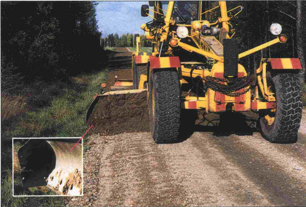
Kuva 10. Stoppari estää karheen valumisen luiskiin.
