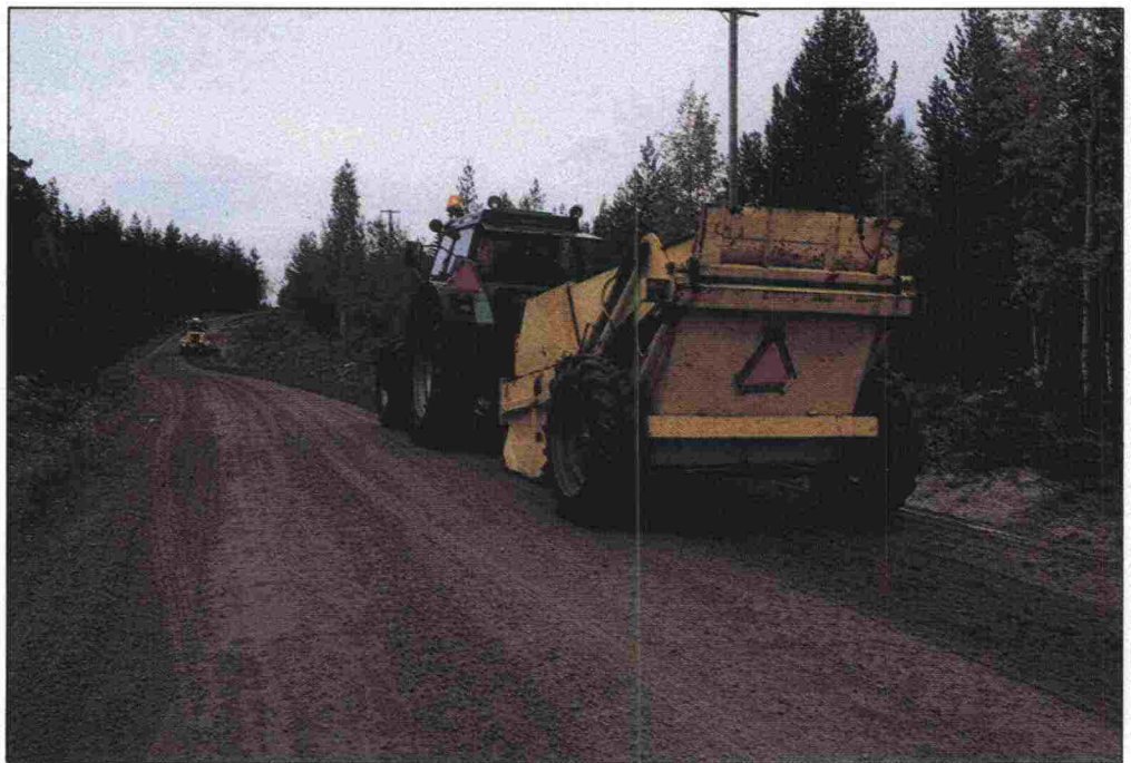
Kuva 13. Oja- ja luiskamateriaalin siirtoa tielle.
