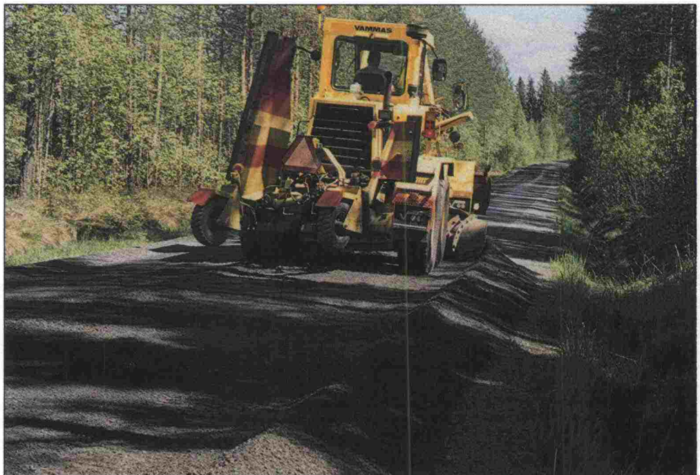
Kuva 4a. Muokkaushöyläyksen irrotusvaiheessa kulutuskerros leikataan kuoppien pohjia myöten ja materiaali siirretään karheelle tien reunoille.
