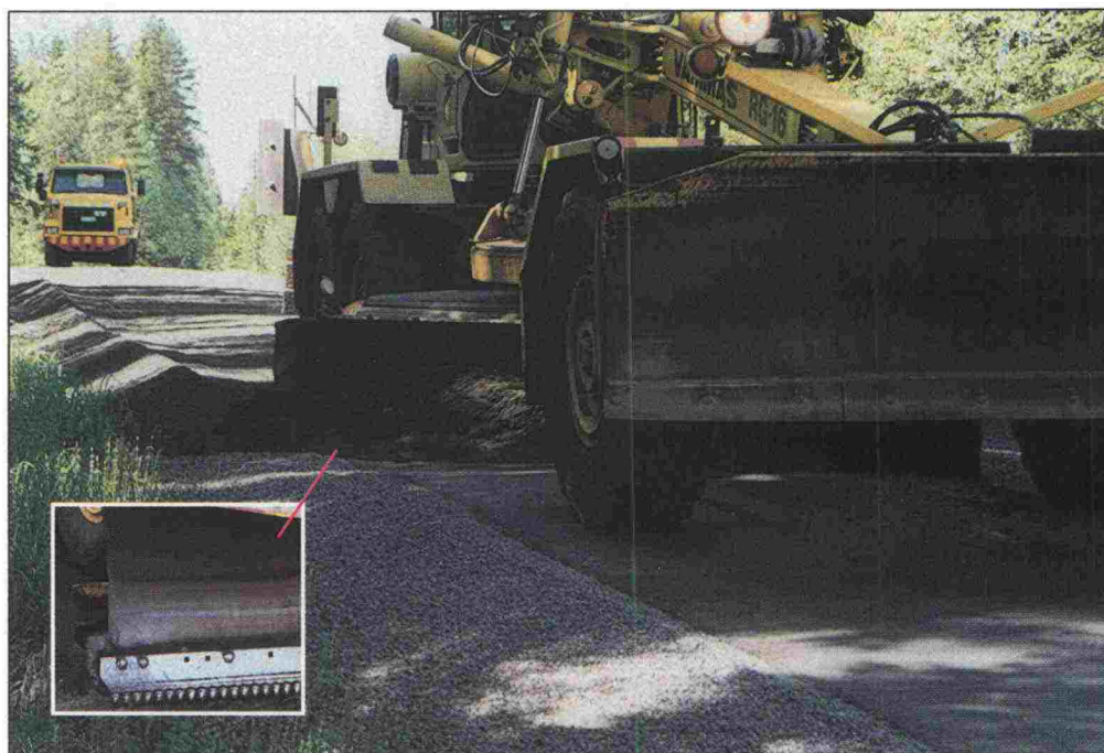
Kuva 5. Tappiterä kulutuskerroksen höyläyksessä.
