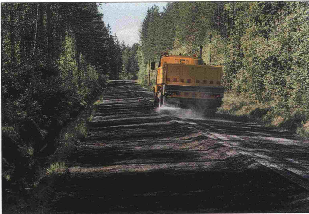
Kuva 7a. Suola levitetään karheen päälle yhdellä levityskerralla.
