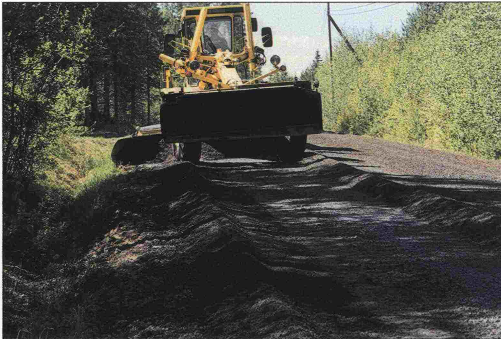
Kuva 4b. Sekoittamista jatketaan siirtämällä materiaali tien keskelle.
