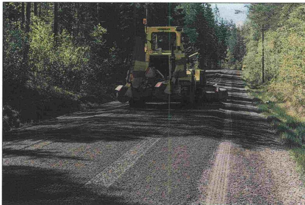
Kuva 7b. Kulutuskerros sekoitetaan ja viimeistellään tiehöylällä.
