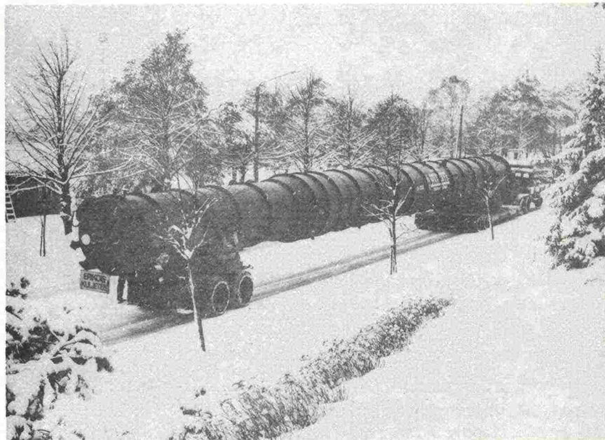
KUVA 5. ERITTÄIN PITKÄT KAPPALEET VOIDAAN KULJETTAA LAVETILLA JA ERIKOISPERÄ- VAUNULLA. TÄSSÄ KULJETETAAN PITKÄÄ KOLONNIA.
