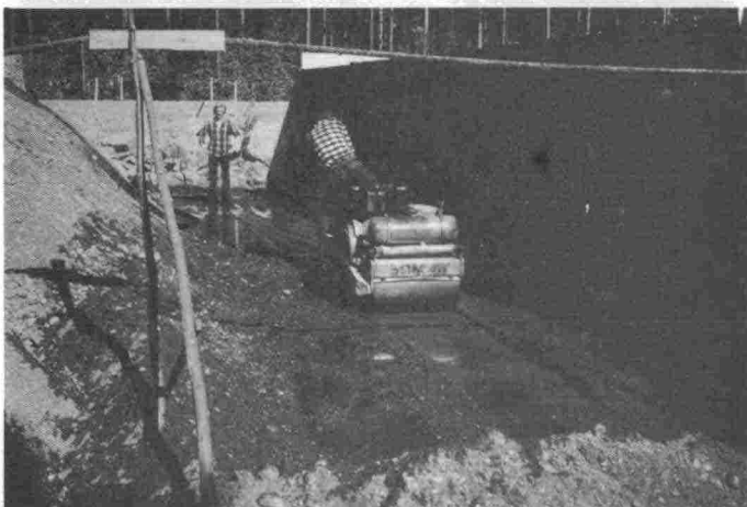
KUVA 26. Työn jatkuminen. Valssivetoista täryjyrää käytetään heti, kun tila sallii.
