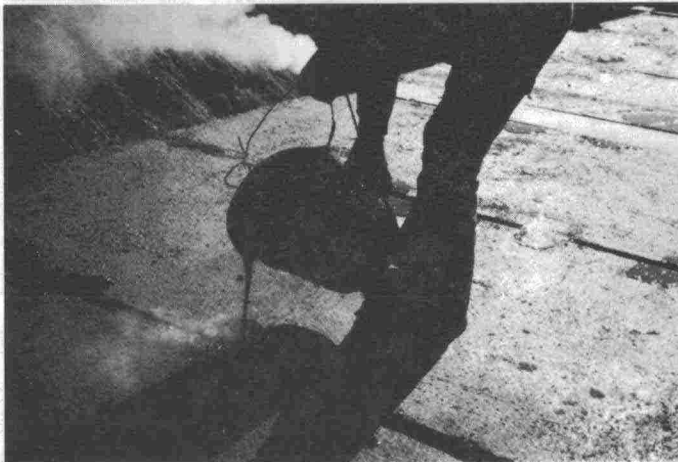
KUVA 22. Kansilaatan saumojen yläosan täyttäminen kumibitumilla.
