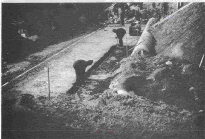
KUVA 7. Asennuspuut upotetaan valmiiseen sora-arinaan.
