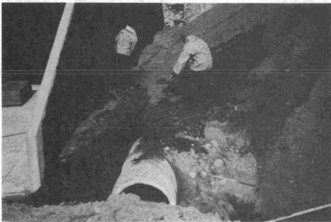
KUVA 25. Työn aloitus. Rummun ja seinän väli tiivistetään kone- tai käsijuntalla.
