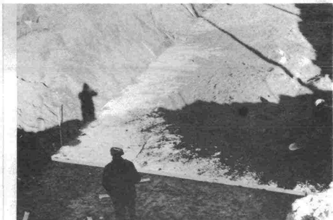
KUVA 5. Eristyslevyjien peittäminen kivet- tömällä hiekalla, levitys lapi- oilla.
