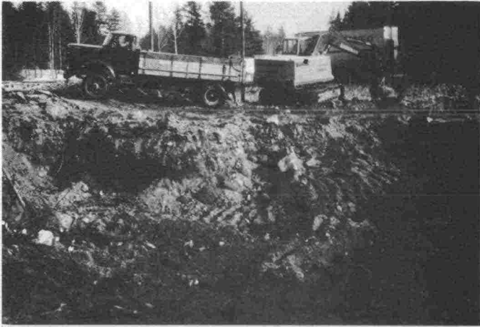
KUVA 1. Maan kaivu. Molemmat päät kaivettu ennen keskikohtaa.
