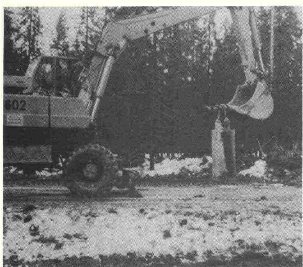
Kuva 2. Jätkäleen nosto
