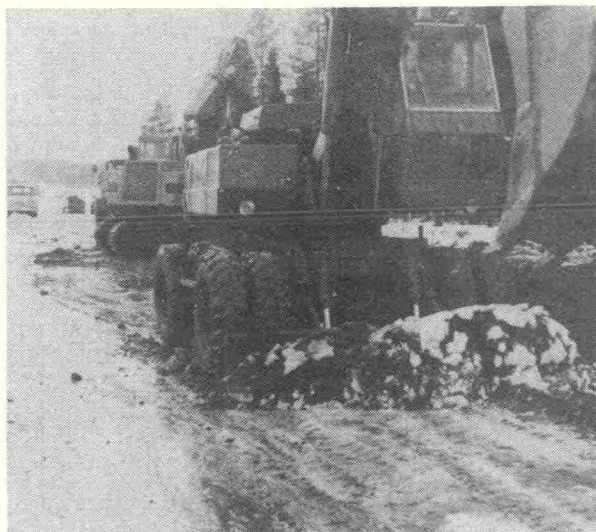
Kuva 1. Alustan puhdistus ennen pudotusjätkäleen käyttöä
