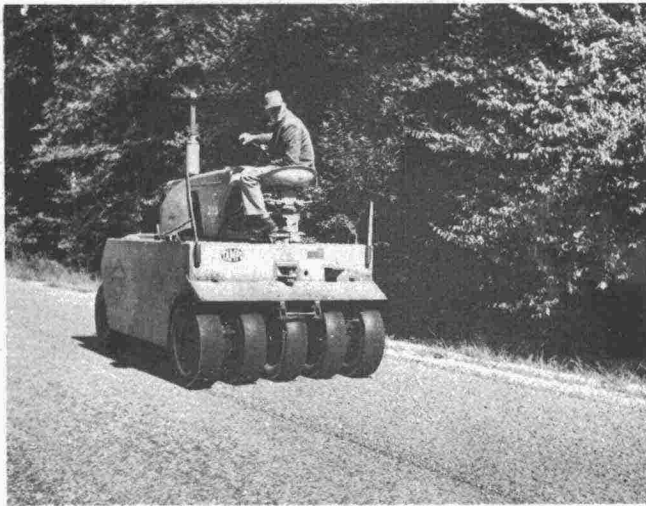
Kuva 27: Jyräys kumipyöräajrällä
