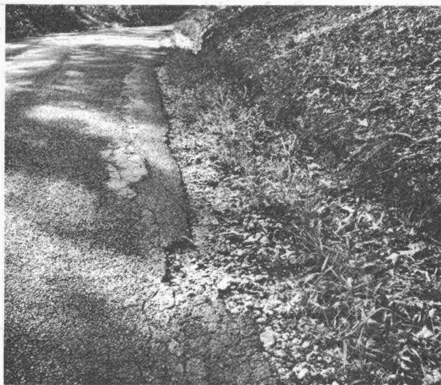
Kuva 8: Purkautu- mia ja murtu- mia päällysteen reunassa
