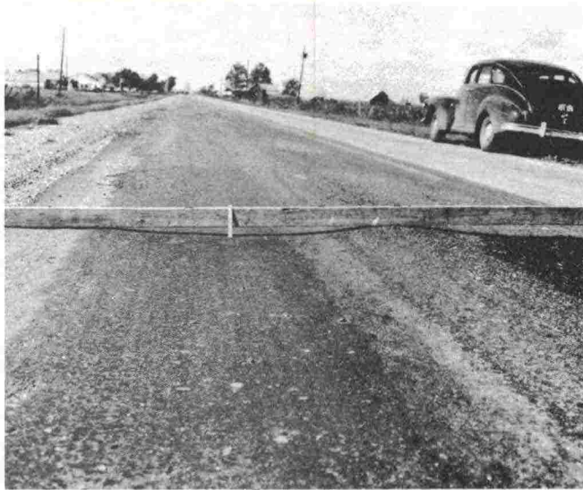
Kuva 11: Kuluneet "raiteet"
