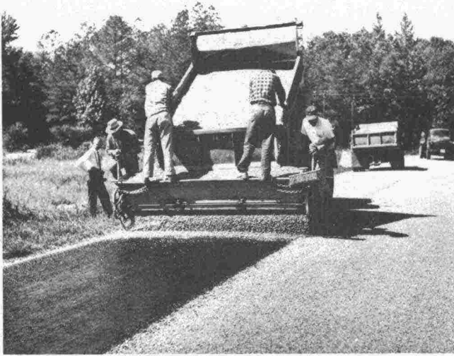
Kuva 26: Sirotteen levitys
