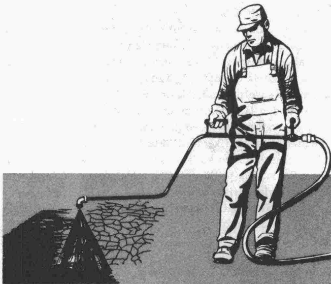
Kuva 34: Sideaineen ruiskutus verkkohalkeamiin
