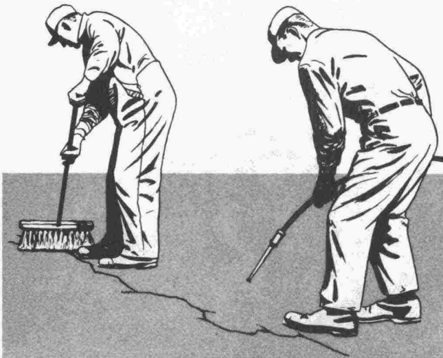
Kuva 37: Halkeama puhdistetaan luudalla tai paineilmalla
