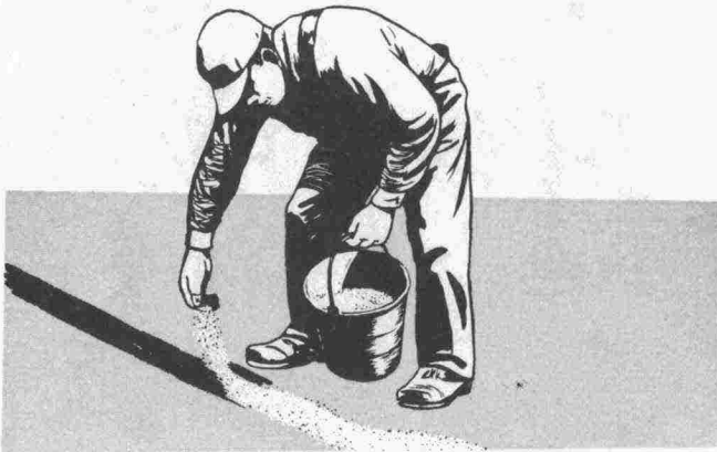
Kuva 39: Saumauskohta peitetään hiekalla tai sirotteella
