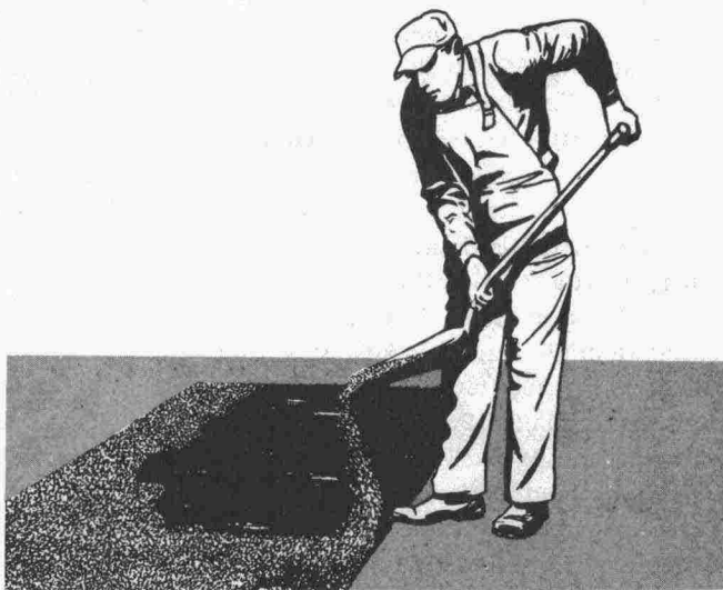
Kuva 35: Sirotteen levitys
