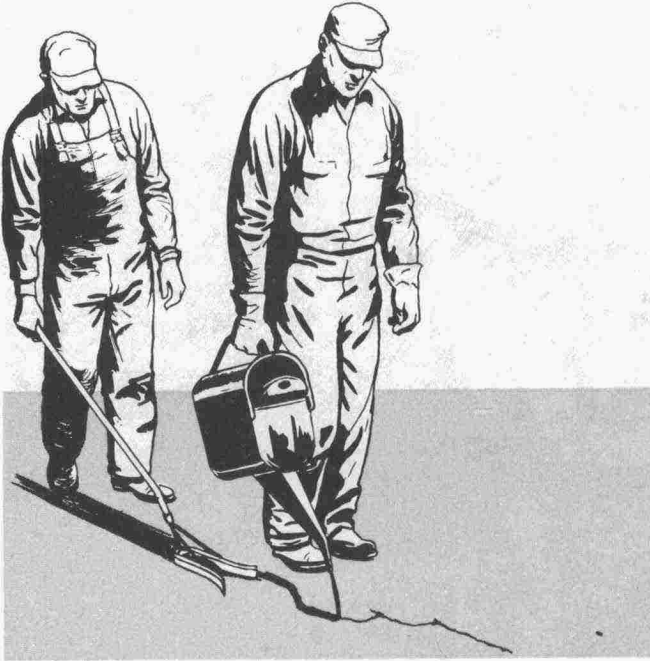
Kuva 38: Sideaine kaadetaan halkeamaan
