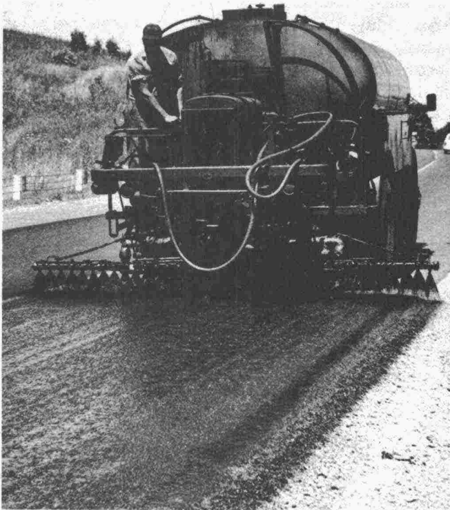
Kuva 25: Sideaineen levitys
