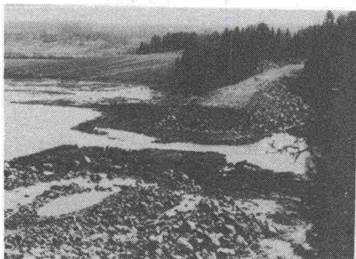
Kuva 2. Paalutetun penkereen sortuma
