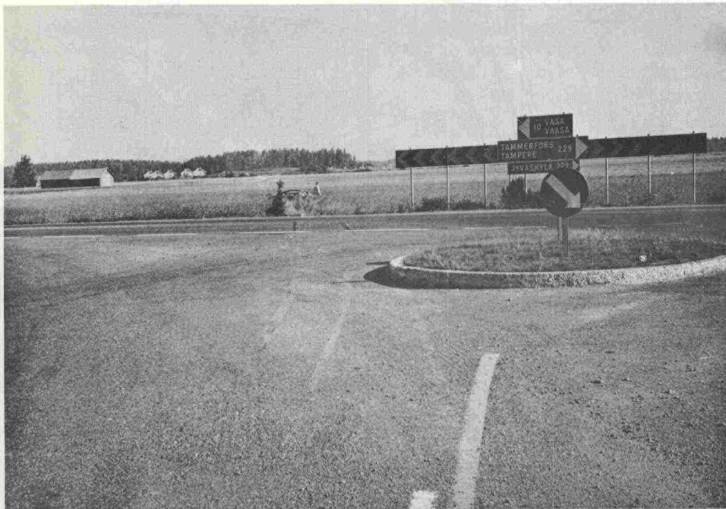
KUVA 7. Tyypillinen Norrholmenin risteyksen onnettomuus. Liikenteenjakaaja on kovalla vauhdilla ohitettu vasemmalta puolelta.
