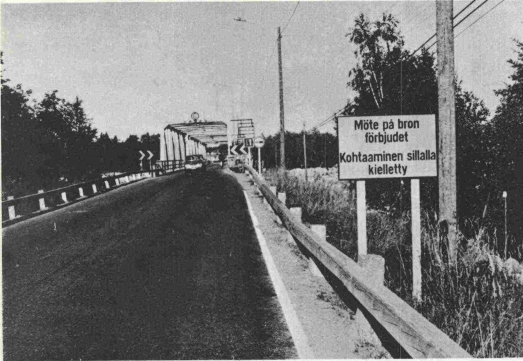
KUVA 10. Perhonjoen silta Kokkolan suunnasta.
