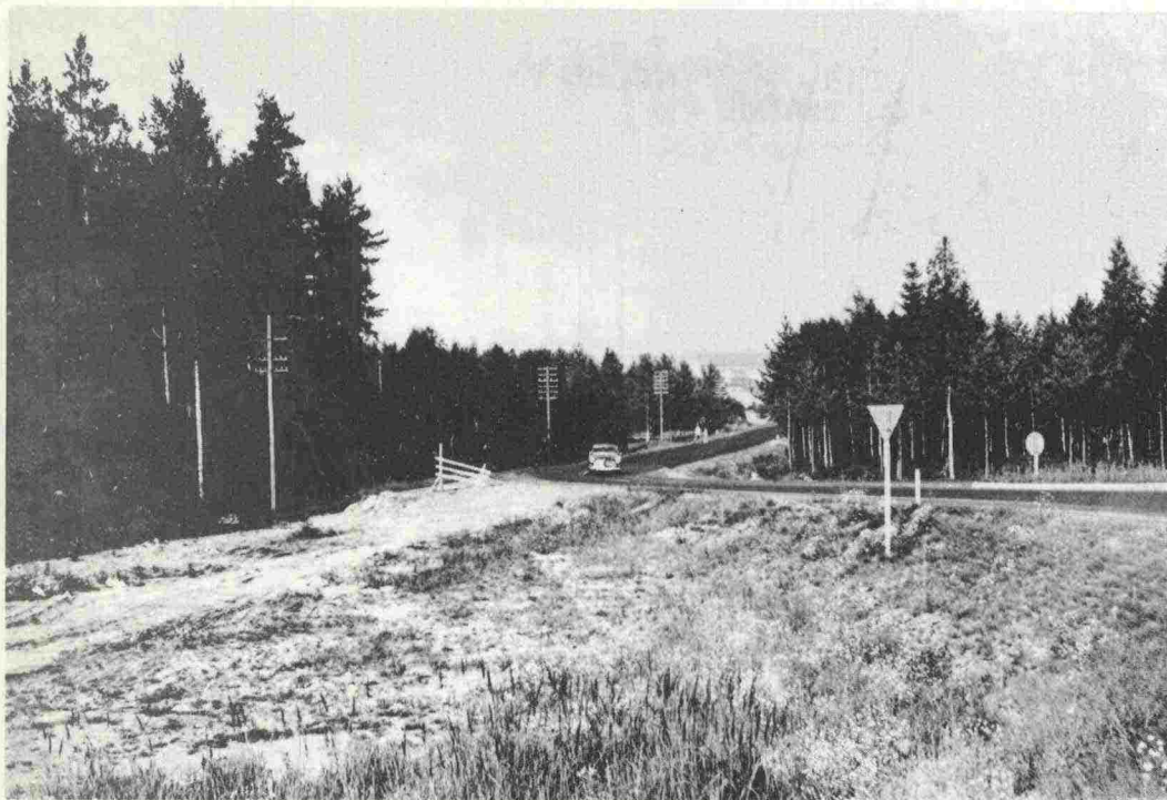
KUVA 3. Tyypillinen autojen kulkureitti liian jyrkässä kaarteessa. Yksikään auto ei tarkkailun aikana pysynyt kokonaan sulkuviivan oikealla puolella.
