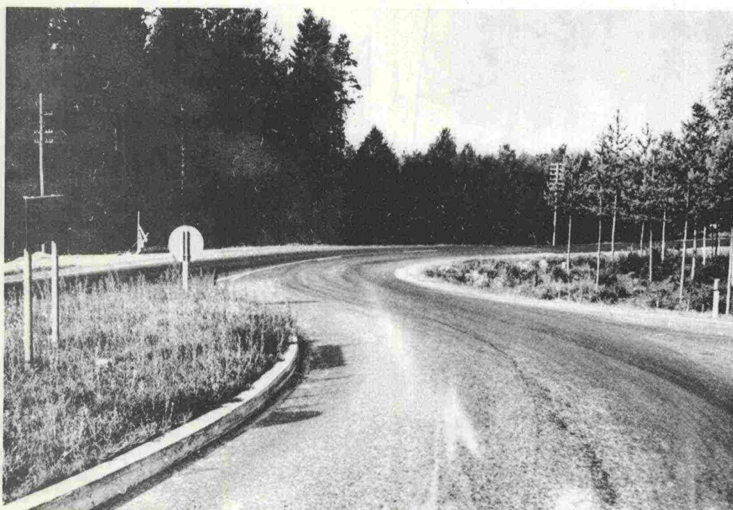
KUVA 4. S-mutka risteyksessä aiheuttaa pitkille ajoneuvoille melkoisia kääntymisvaikeuksia.
