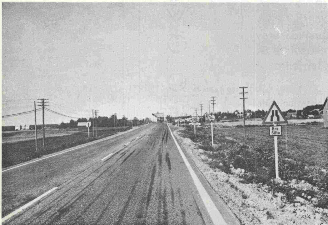
KUVA 8. Ennen koivulahden siltaa on tiessä runsaasti jarrutus- jälkiä, mikä osoittaa nopeusrajoituksen tulevan liian yllättäen.
