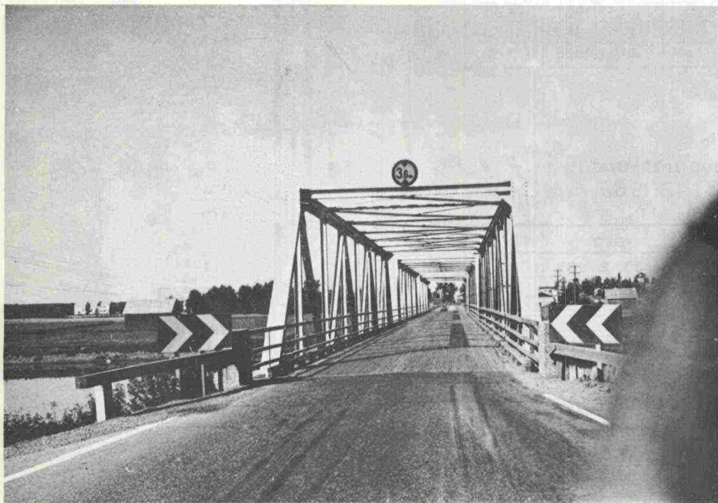
KUVA 9. Koivulahden silta. Jykevä teräsristikko aiheuttaa kuljettajille "suljetunpaikankammon", jolloin koh- taaminen sillalla ei onnistu, vaikka sillan leveys juuri riittäisi.
