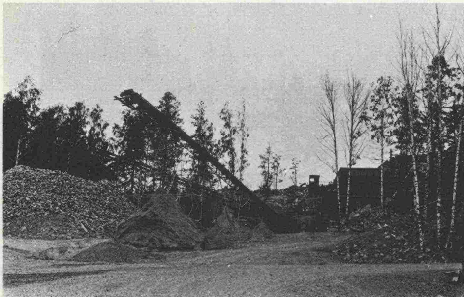
Kuva 15. Aseman n:o 9 esimurskain.
