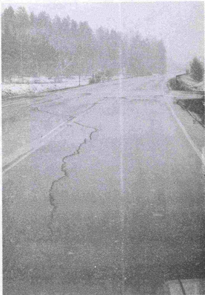
Kuva 2.3 Poikkihalkeama ja päällystesaumahalkeama.
