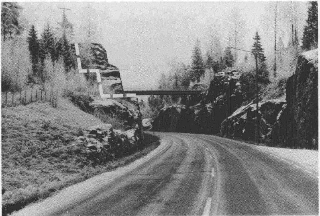
Valokuva 2. Osittain porrastettu jyrkkäpiirteinen kalliroleikkaus. Maisemakuvan parantaminen mahdollista porrastasanteita leventämällä.
