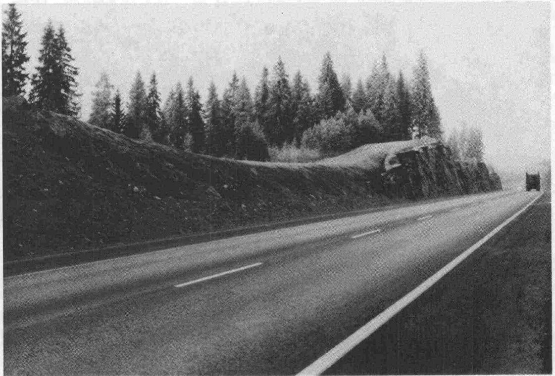
Valokuva 4. Kalliomäen jyrkkiä muotoja pehmennetty irtomassojen avulla.
