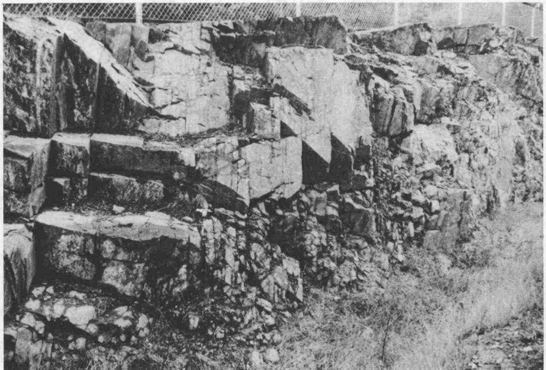
Valokuva 8. Epätasainen louhintajälki runsas-tiheärakoisessa kalliossa. Vallitseva rakoilun suunta epäedullinen leikkaussuuntaan nähden.
