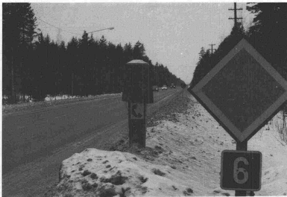
Bild 11.6 Nödtelefonen som inte är i drift har försetts med huv
