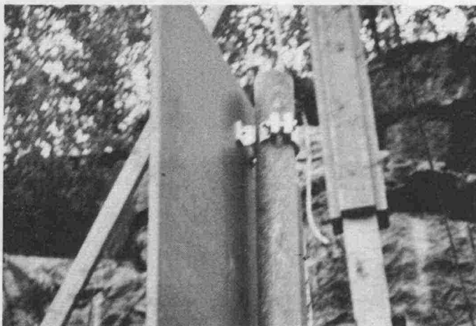
Alumiinikiinnike katkennut
