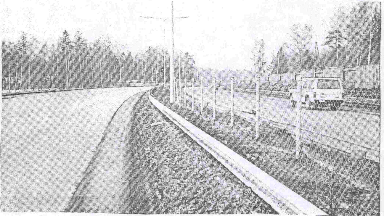
Kuva 28. Keskikaista 4,5 m, Kaiteiden väli 2 m ei riitä lumenvarastointitilaksi. Kuva on otettu vähälumisena talvena (Kehä I, Otaniemi)
