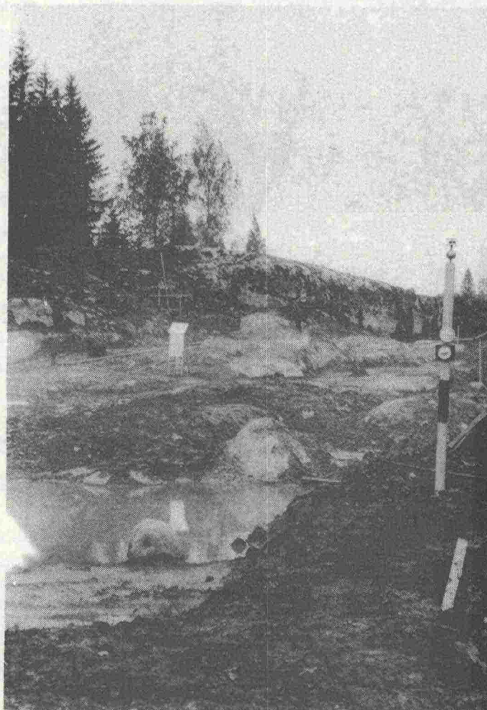
Kuva 47. Lähi- mittaus käyn- nissä työmaal- la 2 c
