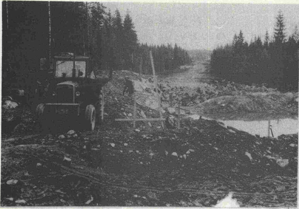
Kuva 46. Yleiskuva työmailta 2 a ja 2 b
