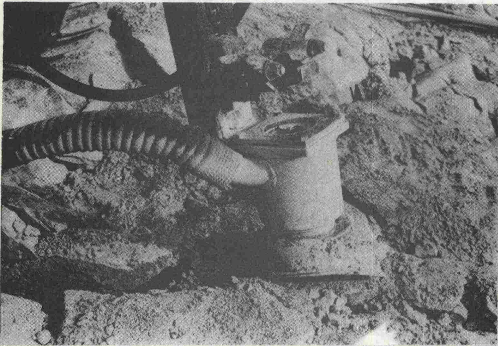
Kuva 50. Pölynpoistolaitteen imukupu
