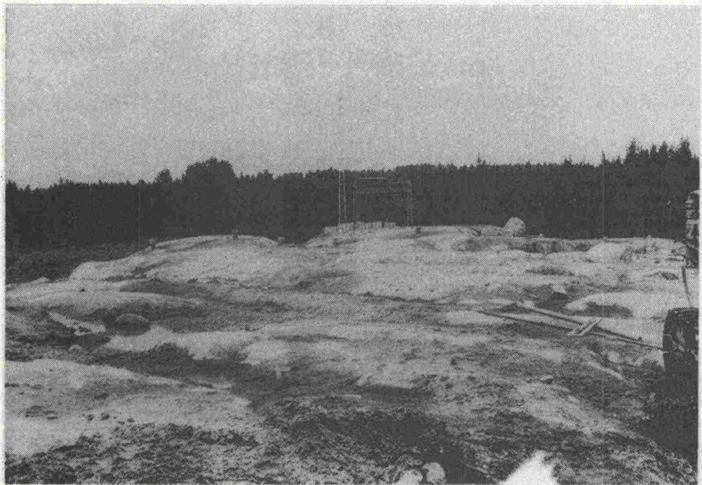
Kuva 48. Yleisnäkymä mittaussuuntaan työmaalla 4
