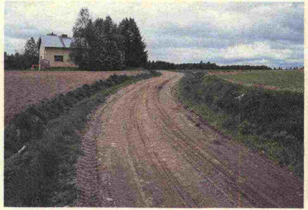
Fig. 10. Kantvallar Kantvallar försvårar vägens dränering, 0 poäng (skala 1-0).
