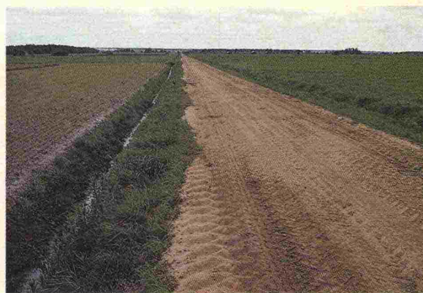
Fig. 6. Materialets kvalitet Slitlagrets material är alltför jämnkornigt, 0 poäng (skala 3-0).
