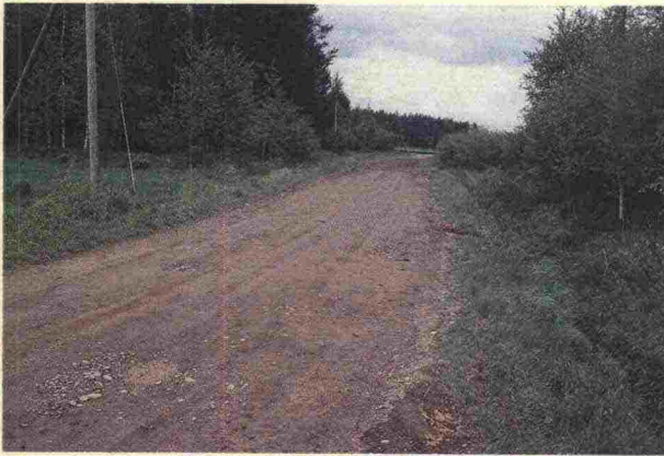
Fig. 11. Hjulspår, potthål, lösa och jordfasta stenar Gropar i vägen försvårar trafik och underhåll, 1 poäng (skala 2-0).
