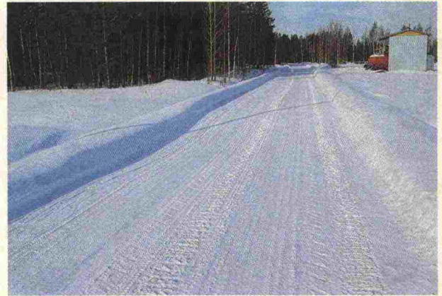
Fig. 18. Lös snö och drivor Ingen lös snö på vägen, 4 poäng (skala 4-0).
