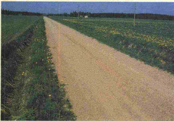
Fig. 13. Dränering, sidodiken Dikena i gott skick, 3 poäng (skala 3-0).
