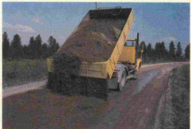
Fig. 42 Spridning av grus med lastbil
