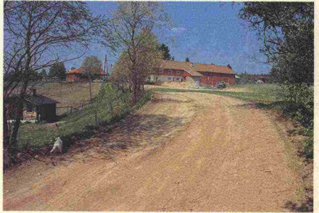
Fig. 12. Hjulspår, potthål, lösa och jordfasta stenar Djupa spår i vägen, 0 poäng (skala 2-0).
