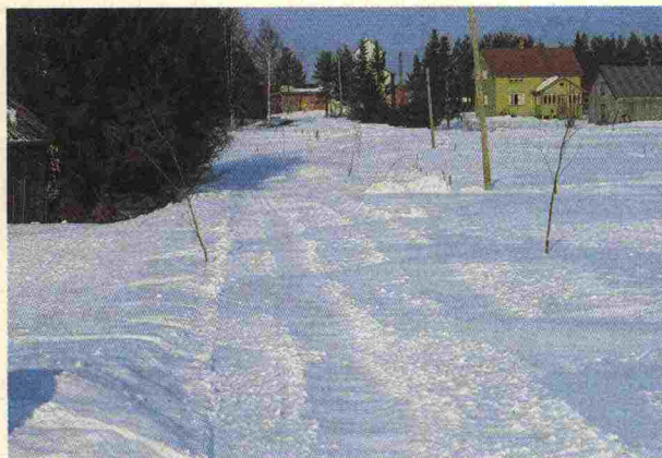
Fig. 19. Lös snö och drivor Lös snö försvårar i hög grad framförande av personbil, 1 poäng (skala 4-0).
