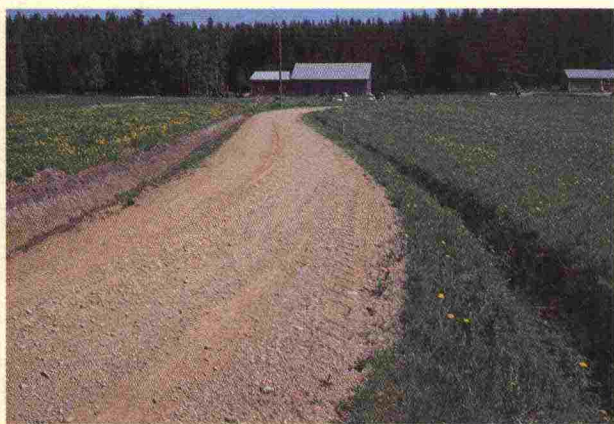
Fig. 7. Materialets mängd Tillräckligt med slitlagermaterial, 3 poäng (skala 3-0).
