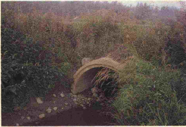
Fig. 15. Dränering, trummor Trumman i försvarligt skick (uppslammad), 1 poäng (skala 2-0).
