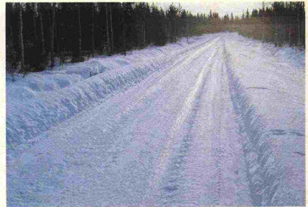
Fig. 20. Hjulspår, packad snö och halka Hjulspår försvårar avsevärt styrning av bil, 0 poäng (skala 1-0).
