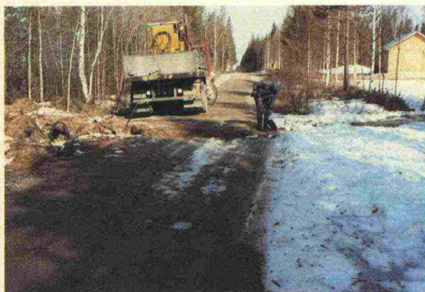
Fig. 40 Öppning av frusen trumma med ånga
