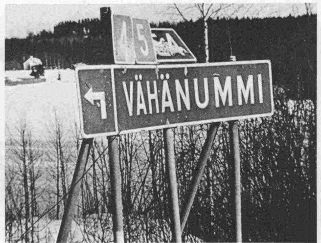
Kuva 2.37 Erilliset kilvet taittuneet
