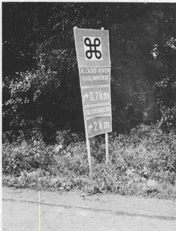
Kuva 2.32 Heikko opastetaulu vaurioitunut. Etäisyys tien reunasta 2 m.
