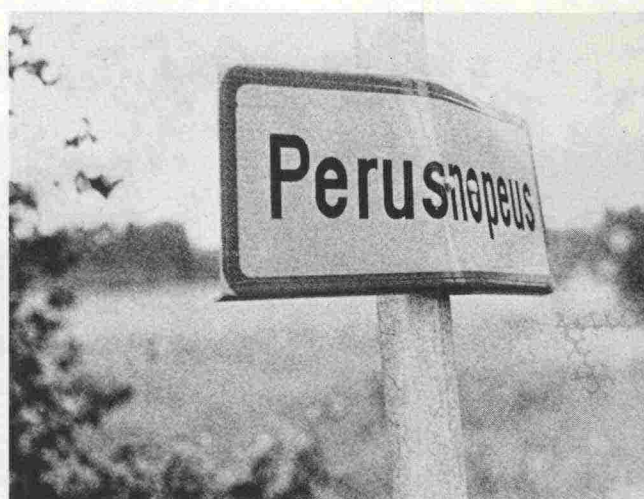
Kuva 2.17 Pahoin vaurioitunut lisäkilpi
