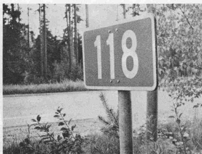
Kuva 2.19 Vanerinen tienumerokilpi on kestävämpi kuin alumiinikilpi
