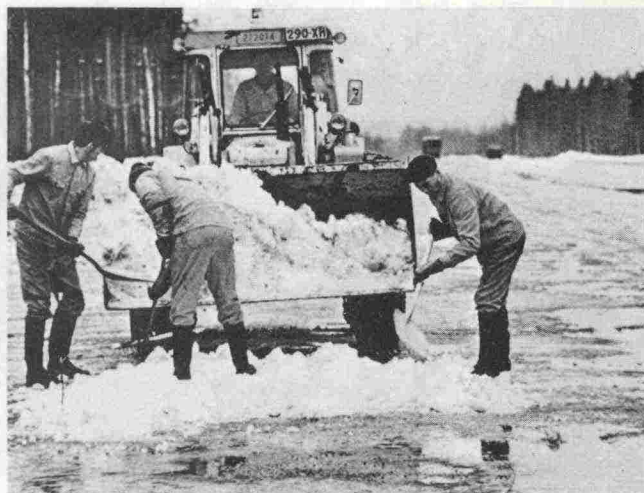
Kuva 2.3 Lumimaton levitystyö käynnissä
