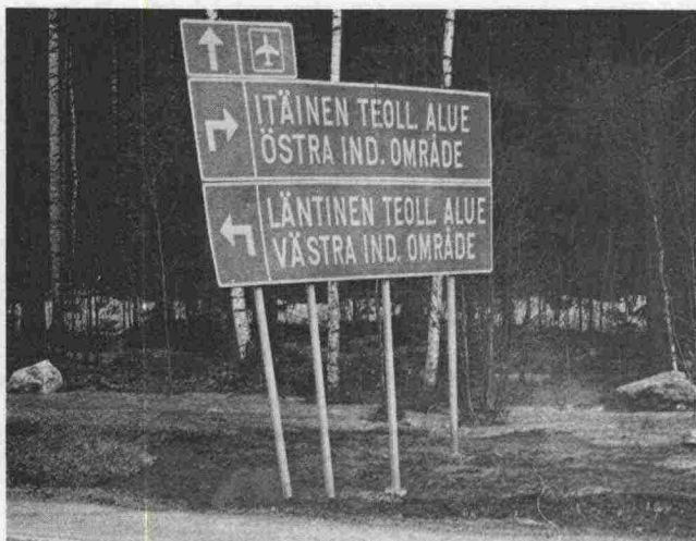
Kuva 2.22 Heikkorakenteinen ja liian lähelle (1.5 m) tien reunaa sijoitettu opastetaulu on pahoin vaurioitunut
