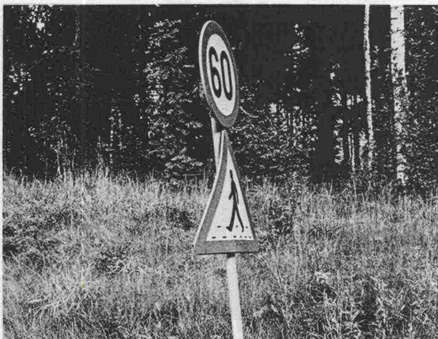
Kuva 2.40 Alimmainen kolmion muotoinen merkki taittunut. Etäisyys 1.3 m ja alareunan korkeus 1.5 m
