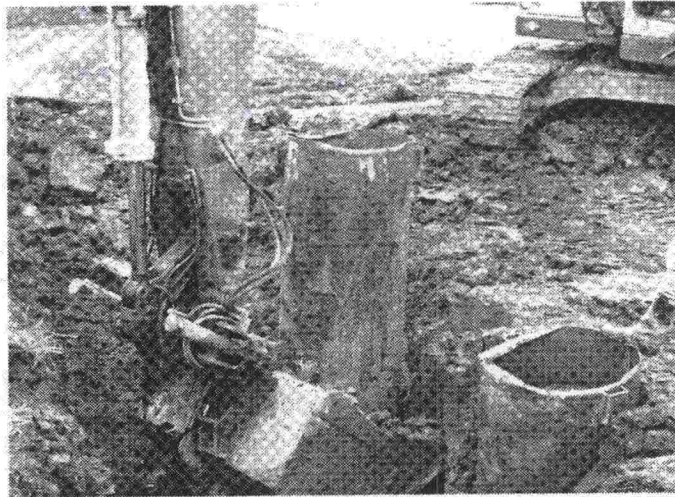
Kuva 2.5 Koepilarin irrotus ja nosto auton lavalle /1, s. 72/.
