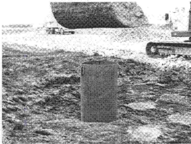
Kuva 2.4 Teräsputken tunkkaaminen koepilarien ympärille /1, s. 72/.
