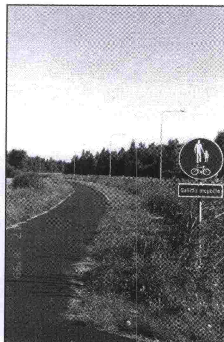
Kuva 8. ... ja jälkeen päällystämisen.
