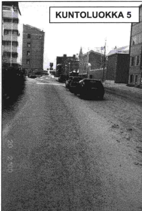
Kuva 106. Tasaiseksi auratun lumipolanteen päälle on levitetty tarpeeksi hiekkaa turvallisen liikkumisen turvaamiseksi. Kuntoluokka 5 (Oulu, Keskusta, 20.2.2000).
