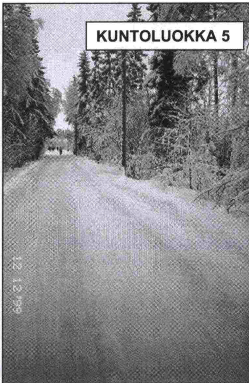
Kuva 97. Erittäin tasainen ja lumesta puhdas väylä. Karhea lumipolanne ei vaadi hiekoitusta. Kuntoluokka 5 = erittäin hyvä. Tutkimusryhmäläisten antamien arvosanojen ka = 4,64 (Oulu, Kuusamontie, 12.12.1999).
