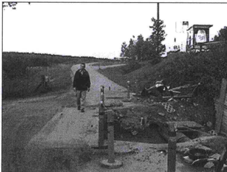
Kuva 31. Turuntien kohteen putkityö (heinäkuusta syyskuuhun)
