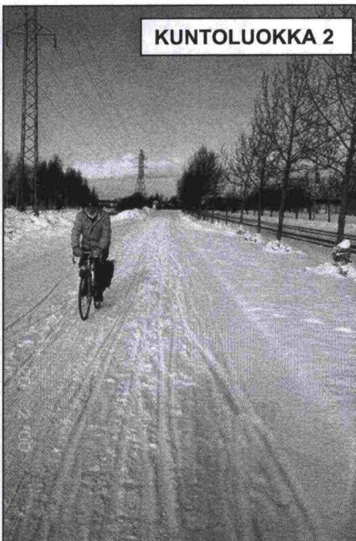
Kuva 100. Epätasaisuus ja lumisuus vaikeuttavat liikennöitävyyttä. Kuntoluokka 2. Tutkimusryhmäläisten antamien arvosanojen ka = 2,08 (Oulu, Limingantulli, 20.2. 2000). Lumi ja epätasaisuus saivat 22 mainintaa kuntoluokkaa alentavana tekijänä.
