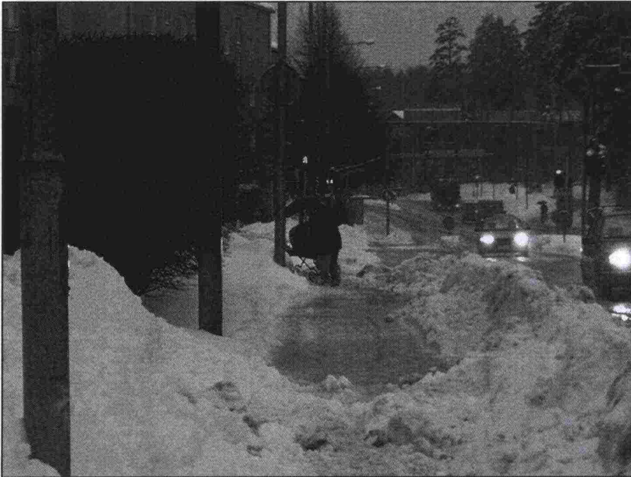
Kuva 72. Tämä kiinteistön hoitovastuulla oleva väylä oli täysin tukossa 13.12.1999. Tarve auraukselle havaittiin aamulla 10:30, eikä väylää ollut aurattu vielä 14:55 mennessä. Kohteella reilu alitus
