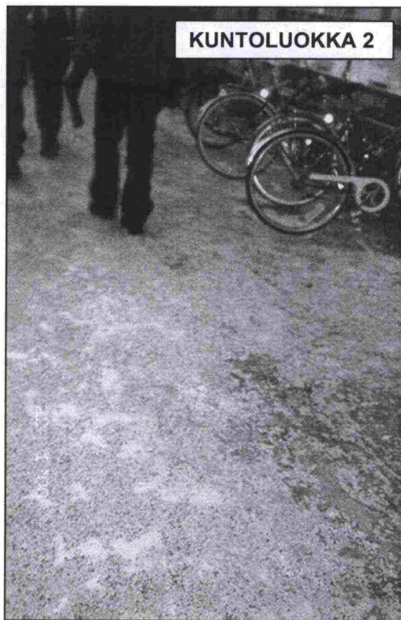
Kuva 111. Epätasaiset ja jäiset kohdat tekivät kohteesta vaarallisen. Kuntoluokka 2. Tutkimusryhmäläisten antamien arvosanojen ka = 2,26 (Oulu, Keskusta, 22.1.2000).
