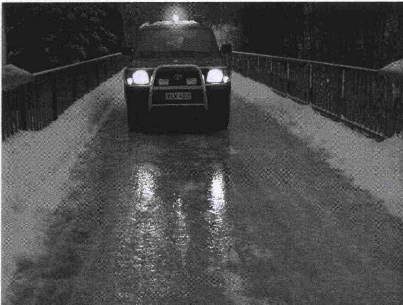
Kuva 71. Tämä kaupungin 2. kunnossapitoluokan kevyen liikenteen väylä oli niitä harvoja kohteita, jotka hoidettiin ajallaan. Kuva otettu 13.12.1999 klo 10:45. Kohde oli hiekoitettu klo 15:25 aikoihin (toimenpideaikaraja 8h)
