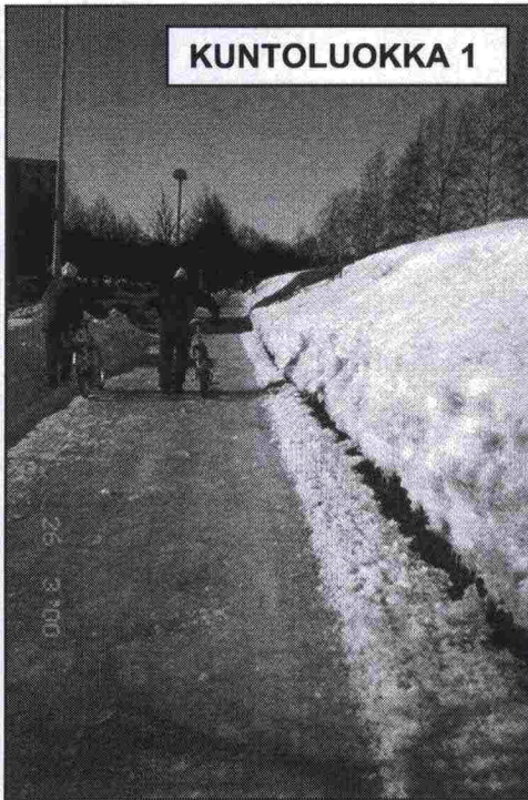
Kuva 104. Väylä oli osittain täysin jäässä, eikä hiekoituksesta ole tietoa-kaan. Kuntoluokka = 1. Tutkimusryhmäläisten antamien arvosanojen ka = 1,09. Kuntoarvoa alentavat tekijät: Liukkaus 21/22, epätasaisuus 19/22. (Oulu, Myllytulli 26.3.2000).
