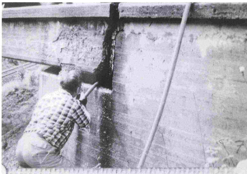
写真28：春には橋を完全に清掃することが大切である。
