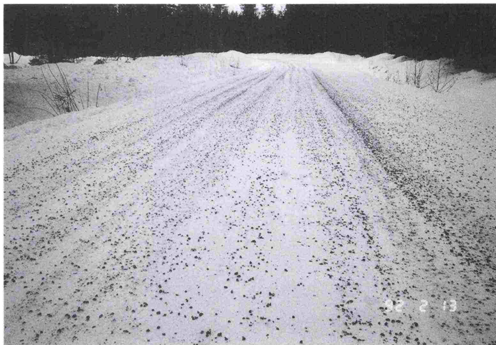
写真36: 圧雪上に散布した4-8mmのマカダム。
