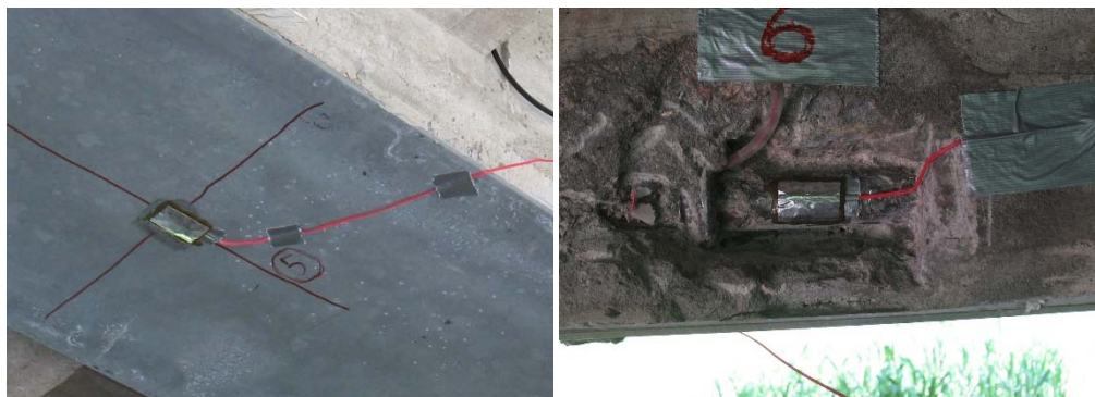
Kuva 10. Venymäliuska kiinnitettynä betonipalkin alapintaan liimattuun levyyn (vasemmalla) ja betonipalkin alapinnan teräkseen (oikealla).
