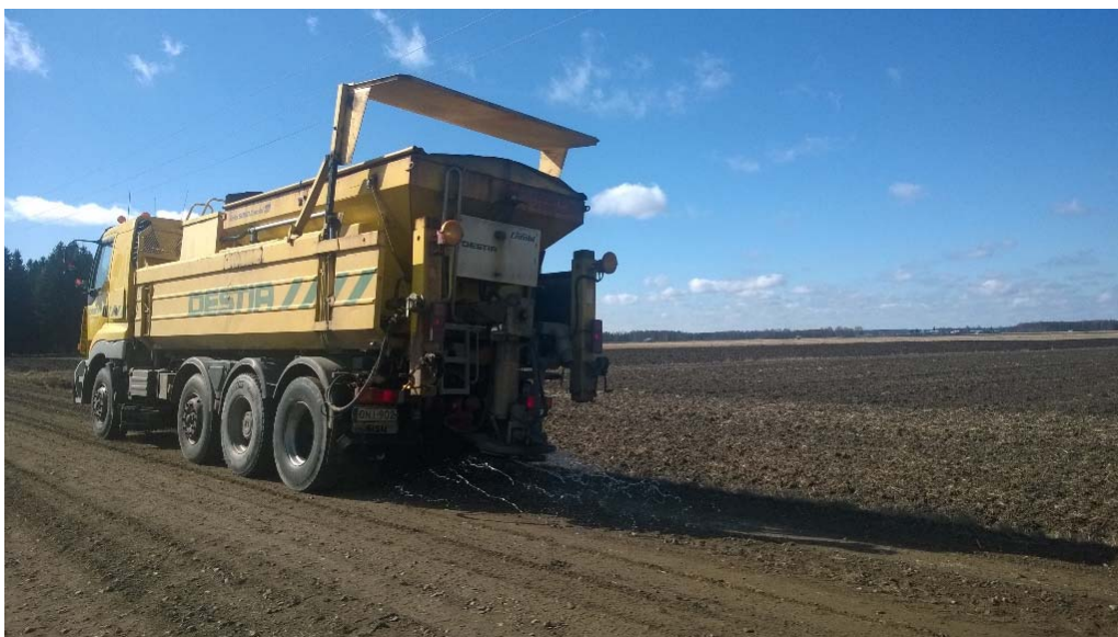
Kuva 11. Biopolymeerin levitystä Jokitiellä 29.4.2016
