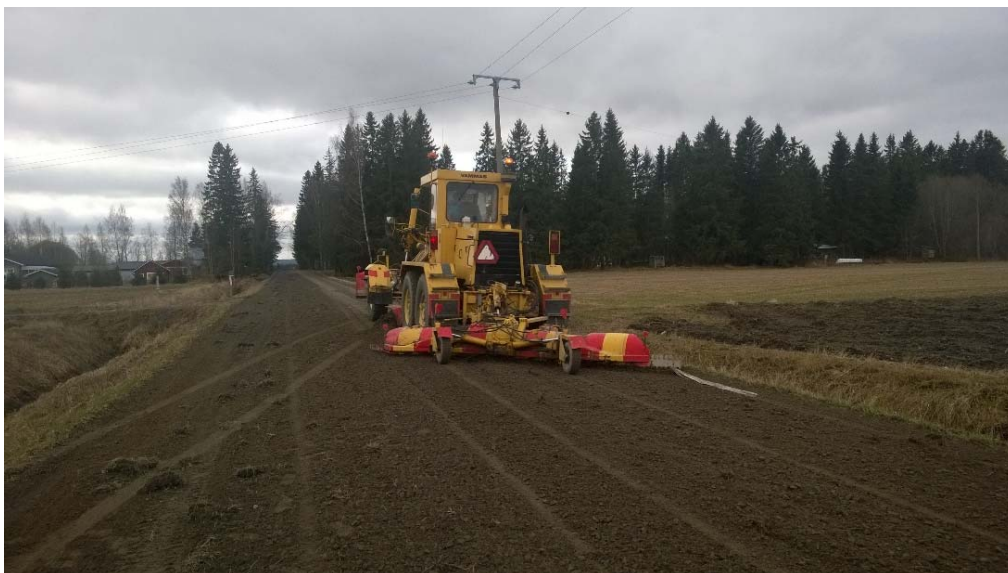
Kuva 10. Tien lanausta Jokitiellä 29.4.2016 ennen biopolymeerien levitystä
