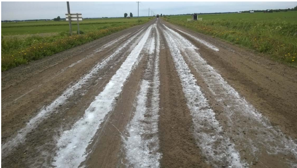
Kuva 7. Biopolymeerien levitystä Jokitielle 10.6.2015
