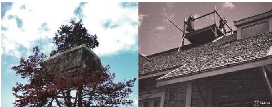
Kuva 8. Vasemmalla on maastoutettu ilmavalvontatorni. Oikealla on talon katolle rakennettu ilmavalvontalava. SA-kuva.
