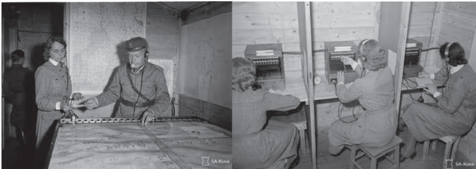
Kuva 15. Kuivissa ovat Mikkelin ilmavalvonta-aluekeskuksen tasopöytä ja erilliset puhelinkopit. SA-kuva.
