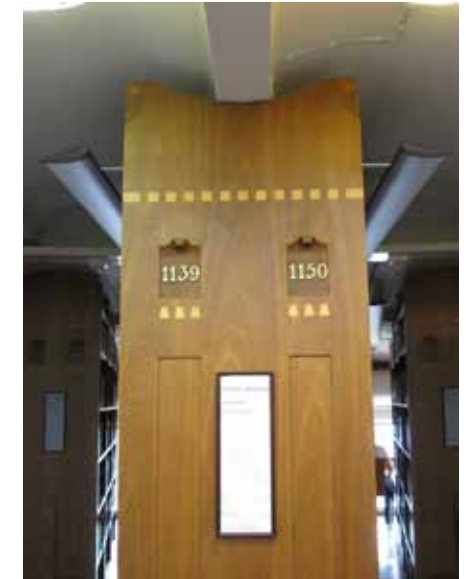
Etupääty palkin kohdalla 6. kerroksessa.
