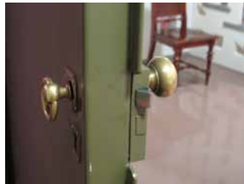
Kupolisiin johtava palo-ovi, joka on tehty Hanssonin peruskorjauksessa uudestaan, mutta vanhoiin heloiin.
