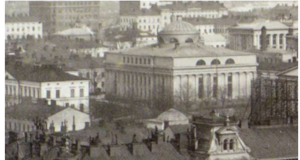
Kuva ennen Farmaseuttisen laitoksen rakentamista (1897). Pihapiiri on väljä ja tontin etelälaidan puurivi vaikuttaa ehjältä. MVKA
