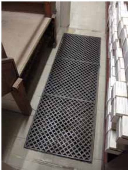
Vanhempi valurautainen ritilä pohjoissalin itäpäässä, peittää kanavaa tms. jonka käyttötarkoitusta ei tunneta.
