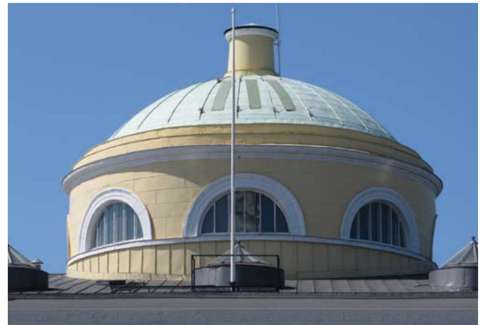
Uudemman ja vanhemman pellin rajapinta erottuu kuvassa selvästi. Vanhemman pellin päällä maalikerrosten tartunta on selvästi heikompaa. Kuva 2011
