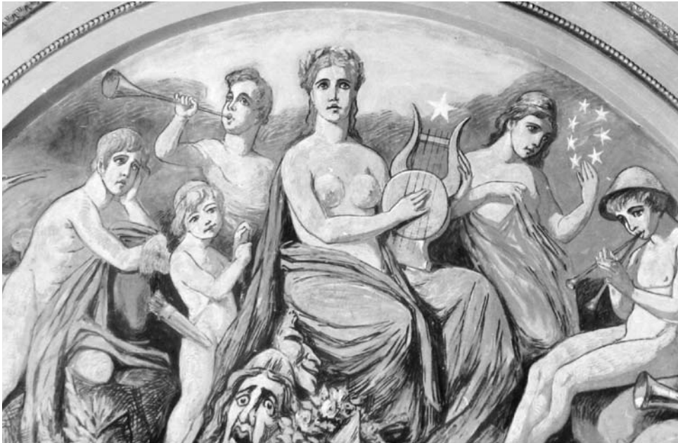
Kupolialin "Runous" 1956 Oskari Niemen johdolla tehdyn konservoinnin jälkeen. Korhonen / HY Kuvalaitos
