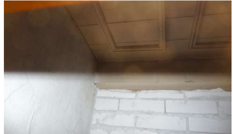
Yllä kupolisalin keskilehterin vanha keskiakselin oviaukko, joka Hanssonin vaiheessa muurattiin umpeen kahitiilellä. Kattopaneloinnissa esiintyy siis oletettavasti 1880-esillä ollut yksivärinen väriyitys. 2011
