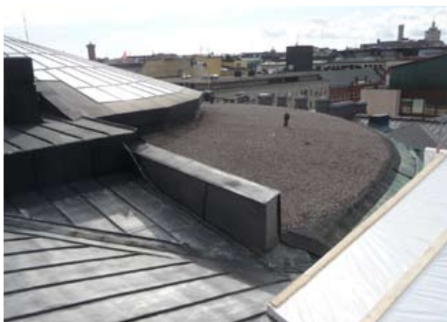
Alla nykyinen Rotundan umpiosan kate, tiettävästi hitsattua bitumikermiä jonka päällä on soraa. 2011.
