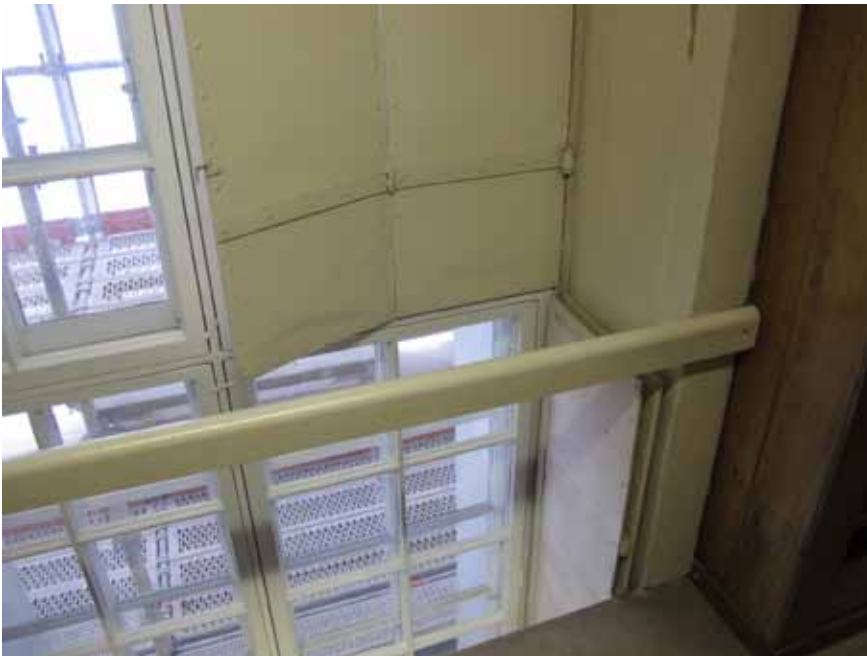
Itäisen ikkunan suojaksi on sisäpuolelle tehty (1880-l?) paksusta rautalevystä niittaamalla kootut palonsuojaluukut.
