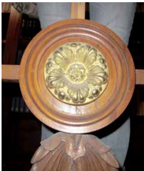
Peruskaiteen (vieressä) messinkipeltinen 5-lehtinen koriste-ruusuke. Kuvassa olevan kaiteen ylempi puinen lehdykkä on irronnut.
