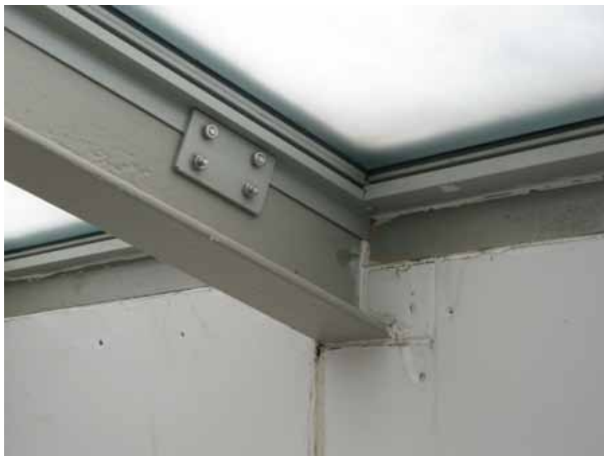
Vesikattorakenteen lämpölasikerros.
