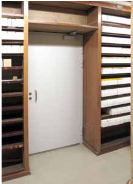
Ovi 3: Ervin suunnitelmien mukaan avattu kulkuyhteys kirjahyllyjen läpi, jossa uudempi palo-osastoiva peltiovi. Kirjahyllyt on yllättäen muokattu Rotundan kirjahyllyjen osilla.
