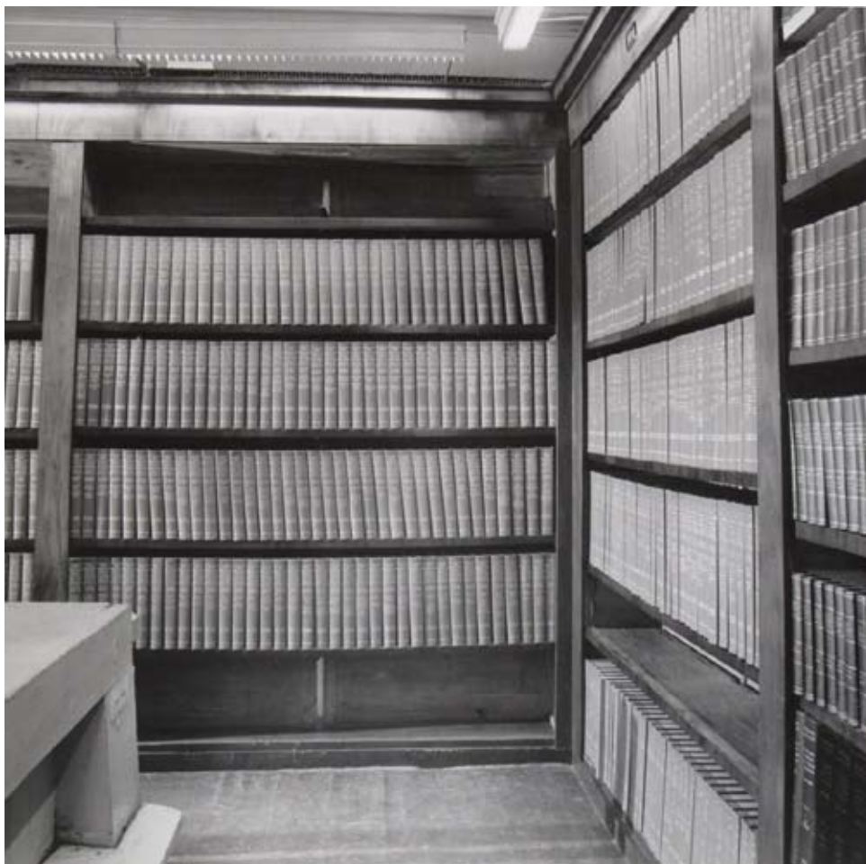
1955-57 muutostöiden jäljiltä kirjahyllyt olivat edelleen pitkälti alkuperäisasussaan, pinnoiltaan restauroituina. Kuvassa näkyy kirjahyllyjen uusi valaistusratkaisu sekä alumiinirakenteinen hyllylevyjien kannatus. KKVA
