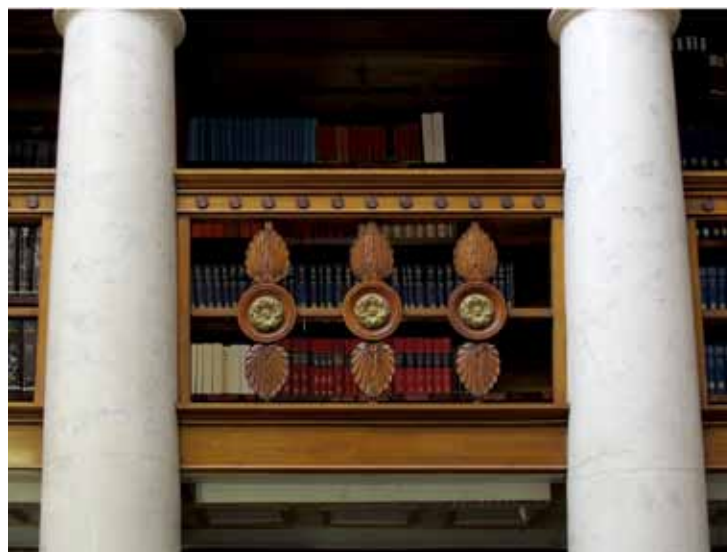
Kipsinen korinttilainen kapiteeli, jonka koristeiden ulkosyrjät on maalattu heleämmällä keltaisella. Vaaleana näkyvä lehdykkä on vuonna 2010 tehdyn korjauksen jäljiltä, tarkoituksella maalaamattomaksi jätetty.
