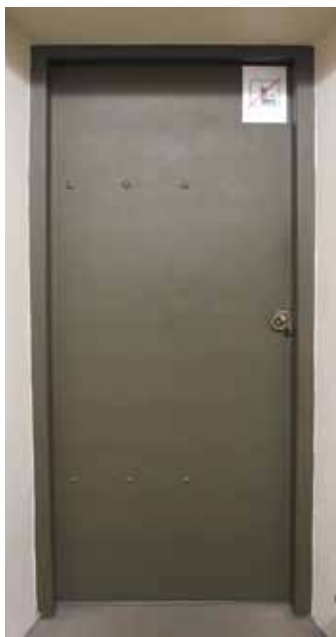
Ovi 1 eli Hanssonin suunnittelema palo-ovi PO23 Rotundan ja kupolisalalin keskilehterin välillä.
