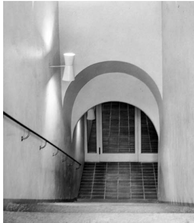
Ervin suunnittelemat porrashuoneen valaisimet on uudemmissa muutostöissä korvattu seinäkiinnitteisillä pallovalaisimilla. Kuva Arkkitehti-lehti/ SRM, julkaistu 1958.
