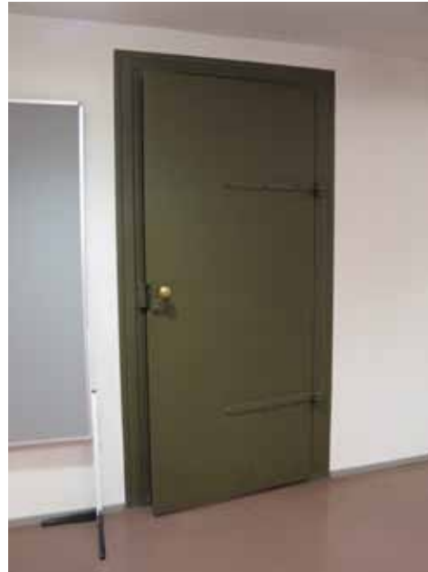
Kupolisiin johtava palo-ovi, joka on tehty Hanssonin peruskorjauksessa uudestaan, mutta vanhoiin heloiin.
