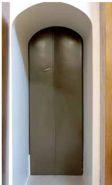
Ovi 2 eli Hanssonin suunnittelema palo-ovi PO22 kupolisalalin ja etelä- ja pohjoissalien välillä, lehterikerroksissa.
