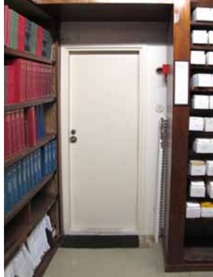
Ovi 4: Jo Engelin aikaan tehty kulkuyhteys pohjoissalista nk. lukusaliin eli nykyiseen vaatesäilöhuoneeseen R119, johon Hanssonin suunnitelman mukaan lisätty palo-osastoiva peltiovi.
