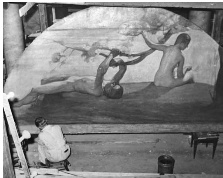
Tiettävästi maalari Oskari Niemen johdolla vuosina 1955...56 kunnostettu Enckellin maalaus, kuvassa irrotettuna paikaltaan.
