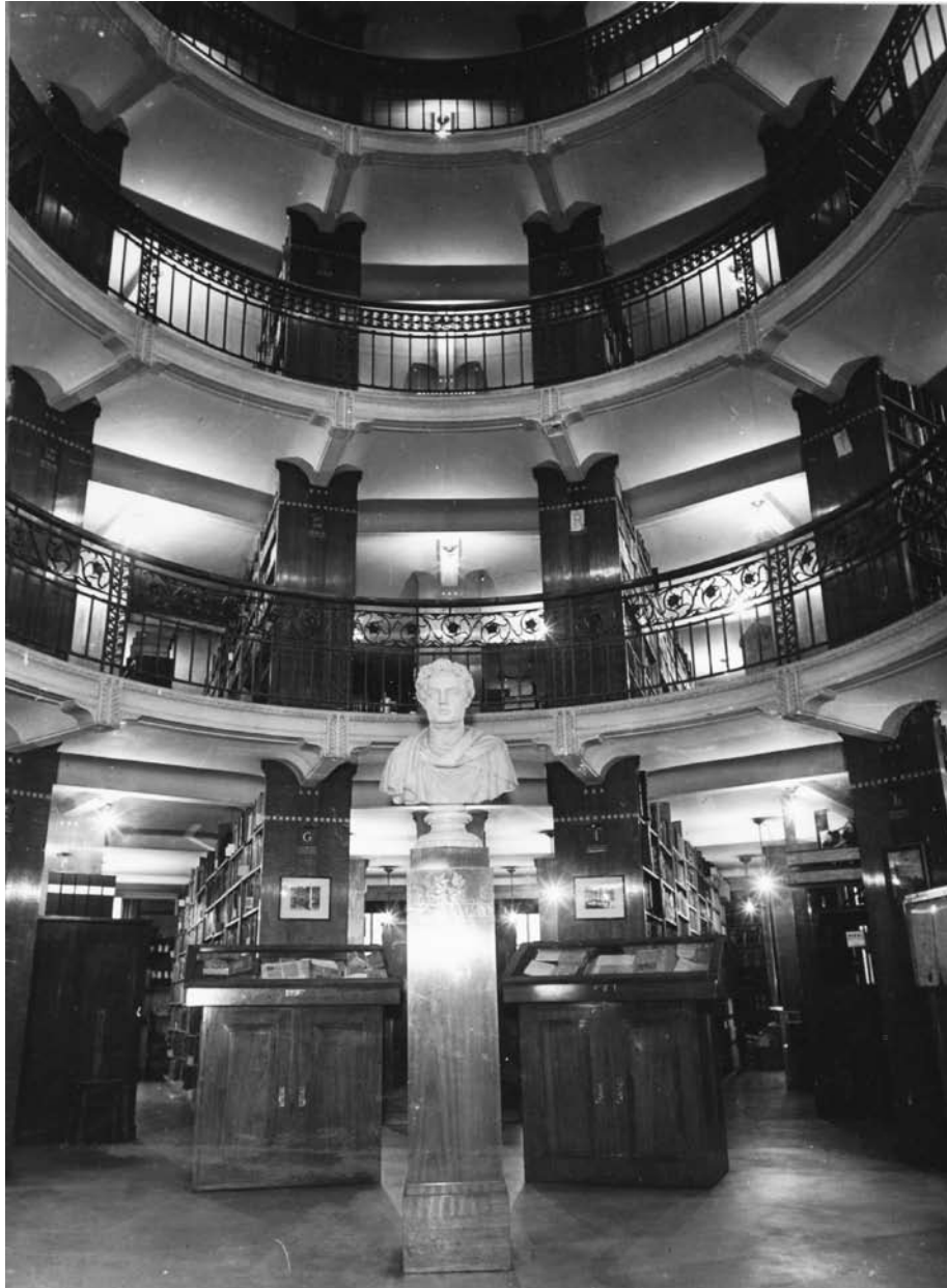
Ennen peruskorjausta: dokumentoitu kuva vuodelta 1950 tai -51. Rotundan, eli kirjavaraston, kirjahyllyjen välinen valaistus perustuu paljaisiin hehkulamppuihin. Lintunen / HYM
