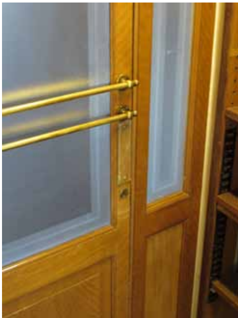
Nyströmin vaiheesta säilynyt, oletettavasti mahonkinen väliovi, jossa etsatut koristelasit ja messinkihelat Rotundan 5. kerroksessa
