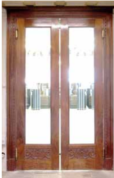
Ovi 1, tiettävästi Nyströmin suunnittelema mahonkipintainen heiluriovi, jossa alapeileissä koristeleikkaukset ja lasissa etsatut kasviornamenttikoristeet.
