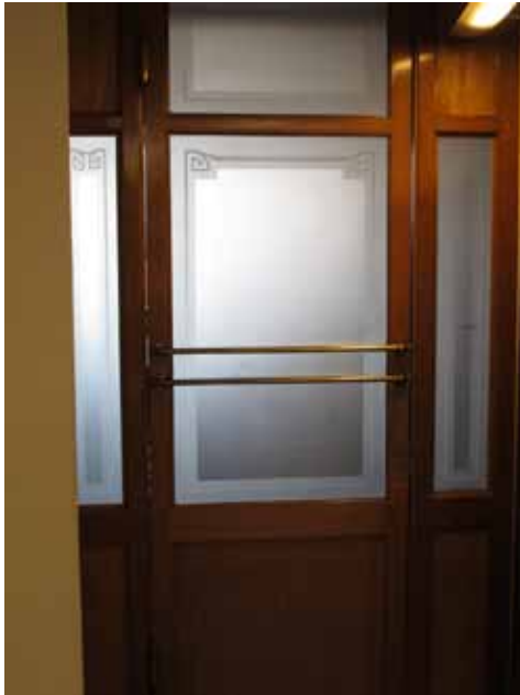
Nyströmin vaiheesta säilynyt, oletettavasti mahonkinen väliovi, jossa etsatut koristelasit ja messinkihelat Rotundan 5. kerroksessa
