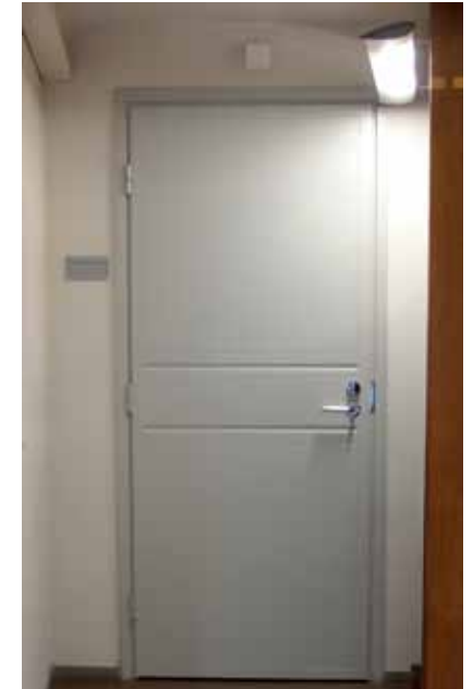
LPR:n suunnittelema työhuonetilojen laakaovi, kehysoven yksityiskohtiin etäisesti viittaavin koristeurin varustettuna.
