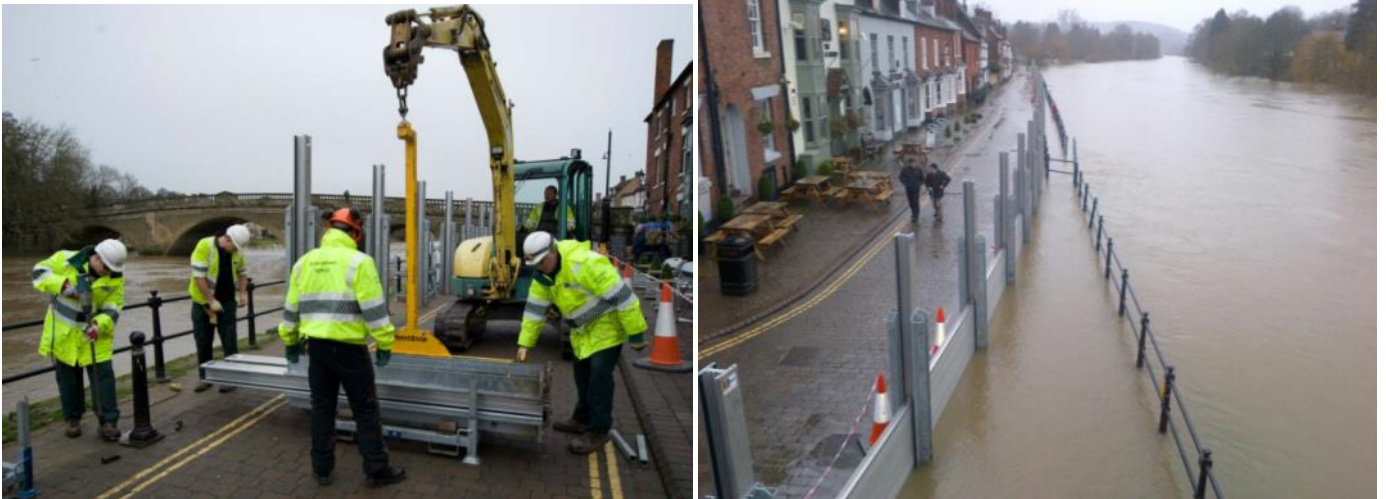
Kuva 64. Tilapäinen tulvaseinä suojaa asutusta Severn-joen tulvalta Iso-Britanniassa keväällä 2014. (©Environment Agency)
