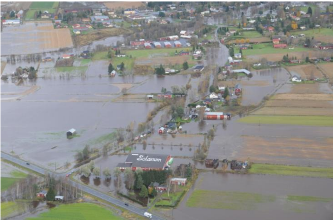
Kuva 25. Syksyn 2012 tulva levisi rakennetuille alueille Lapväärtin taajamassa. (Unto Tapio)
