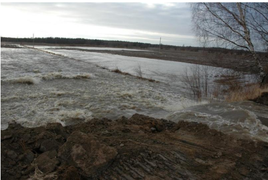
Kuva 27. Lapväärtinjoen alaosalle avattiin pengeri tulvavahinkojen vähentämiseksi keväällä 2013 (Kim Klemola)
