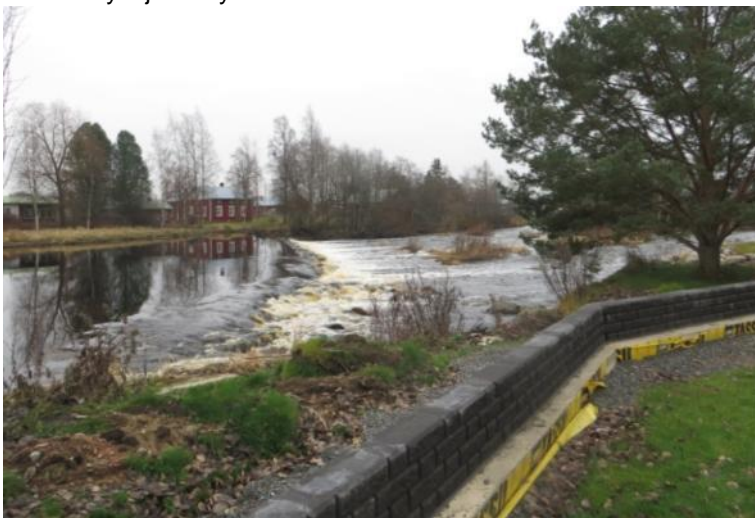
Kuva 46. Esimerkkejä ensimmäisen vaiheen aikana Lapväärtiin rakennetuista tulvapenkereistä ja –seinistä Holmforsin (vas.) ja Uudensillan (oik.) kohdilta. (Liisa Maria Rautio)
