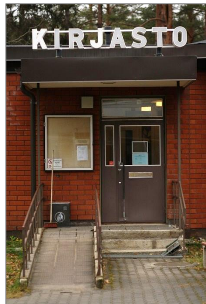
Kuva 60. Palvelukohteiden sisäänkäyntien esteettömyydessä on kehitettävää. Valtimon kirjaston portaista puuttuu kontrastiraidat.
