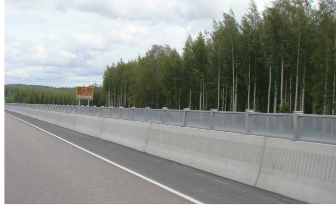
Kuva 5.12. Meluntorjunta saadaan sovitettua osaksi valtatieympäristöä hyvällä meluestetyypillä.
