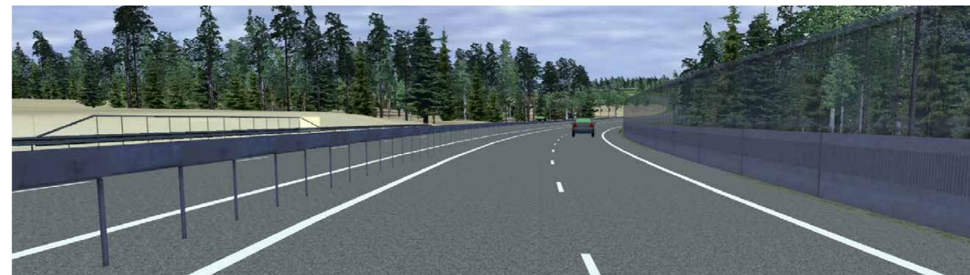
Kuva 5.9. Valtatien varrelle toteutetaan tehokas meluntorjunta, jossa käytetään myös läpinäkyviä osia autoilijoiden näkymien turvaamiseksi.
