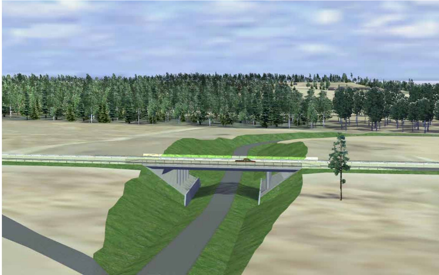
Kuva 4.17. Kähärilän vihersilta turvaa eläinten liikkumisen tien poikki.
