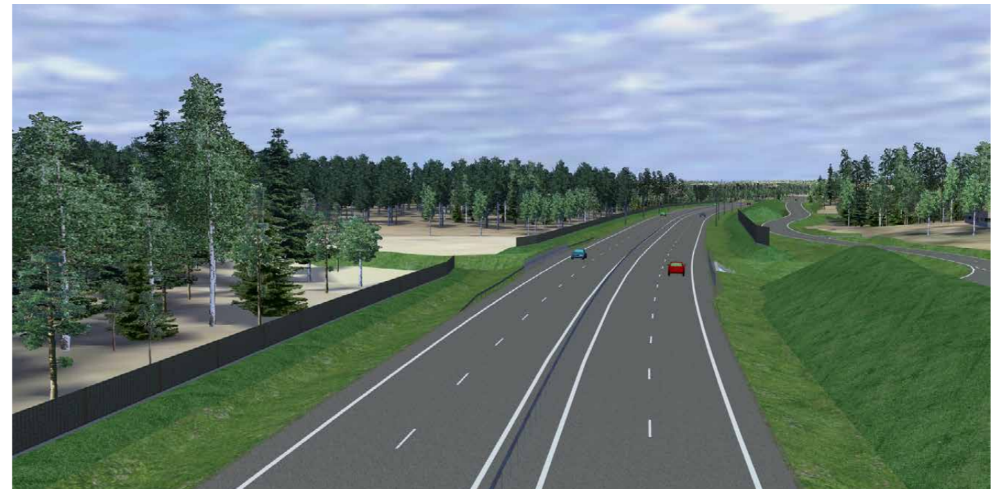
Kuva 4.21. Valtatie 13 varten toteutetaan tehokas meluntorjunta ja jatkuva rinnakkaistiestö. Havainnekuva Akkamäen kohdalta Lappeenrannan suuntaan.
