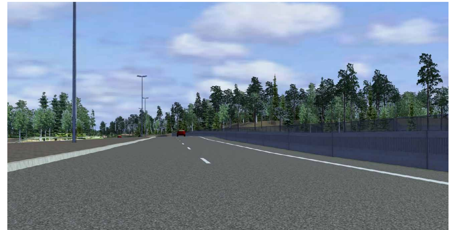
Kuva 4.18. Melukaiteiden yläosassa voidaan käyttää läpinäkyviä osia. Havainnekuva Rasalantien kohdalta.
