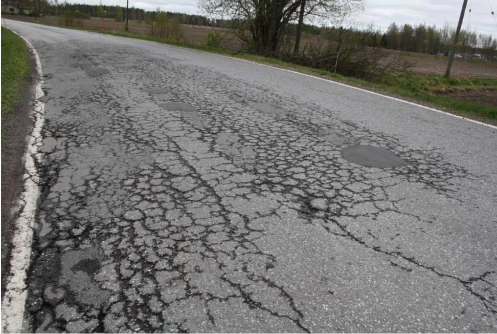
Kuva 26 Verkkohalkeiluun edennyttä väsymishalkeilua (Elina Lätti 2015)
