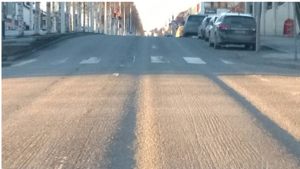
Kuva 32 Syvät nastarengasurat (Korpihalli 2015)
