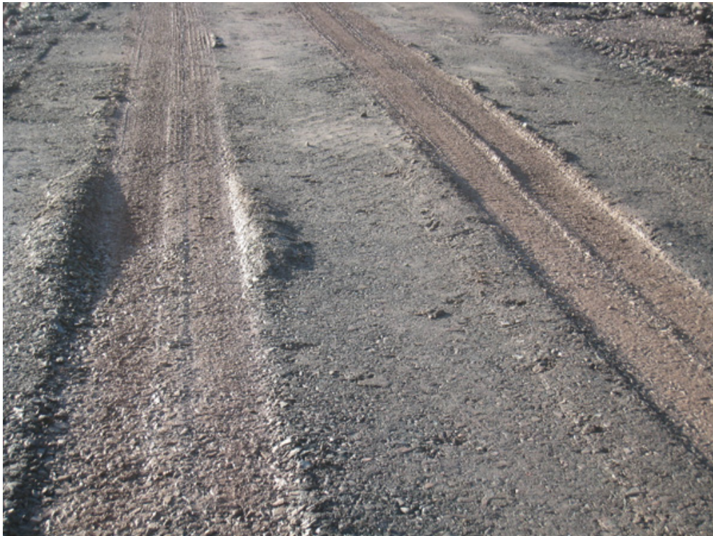
Kuva 29 Kulutuskerroksen tiivistymisestä ja sitomattoman kerroksen deformaatiosta aiheutuvaa urautumista sorapintaisessa tierakenteessa (Roadex e-Learning)
