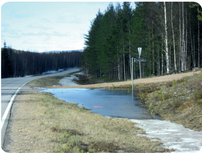
Jäätynyt rumpu estää veden virtaamisen ojassa ja vedet valuvat tielle. (Kuva: Timo Saarenketo)
