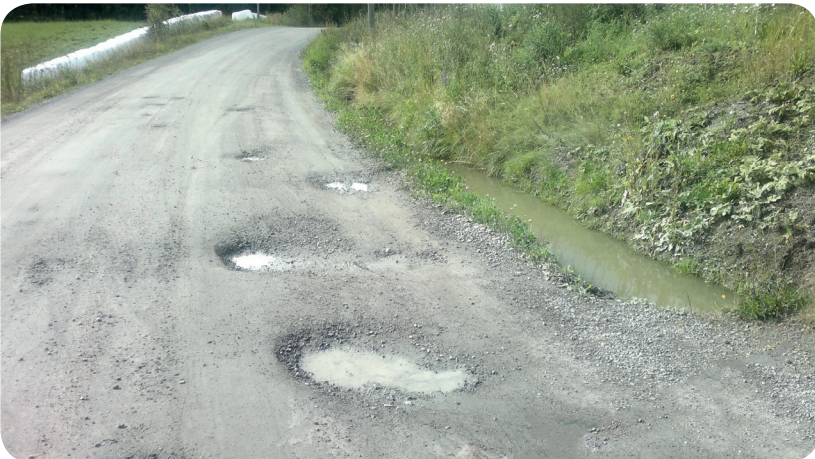
Tierakenteeseen imeytyneen veden aiheuttamia kuoppia. (Kuva: Raija Kreutzer)
