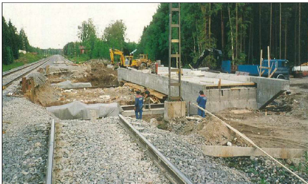
Kuva 2.5 Sillan siirtokaivanto, siirtoradat ja kansi valmiina siirtoa varten. [15]
