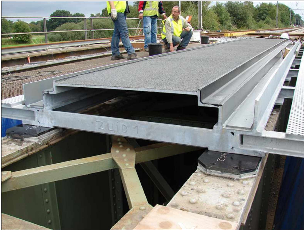
Kuva 5.9 Levyrakenteinen ERS-elementti asennettuna pääkannattajien ylälaip-poihin valmistettujen tasoitettujen kiinnitysalustojen päälle saneeraus-kohteessa.
