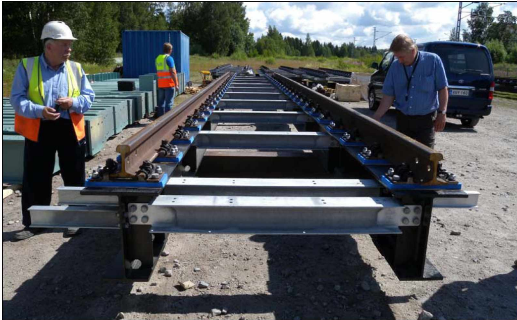
Kuva 5.3 Kiskot suorakiinnityksellä sekundääripituuskannattajien päällä. Joustolevyt on asennettu kiskonkiinnityslevyjen alle. Poikkituet on rei'itetty suojakiskojen asennusta varten. Kuvassa Paimionjoen ratasillan sekundääripituuskannattajat esivalmisteisena elementtirakenteena.
