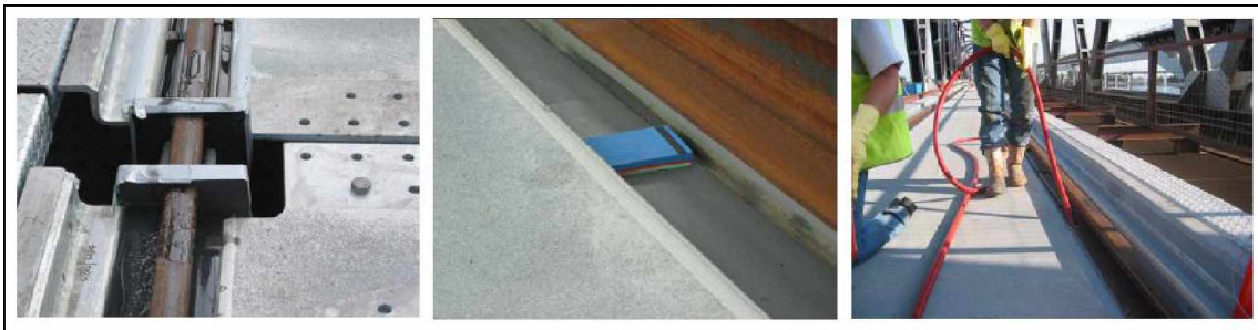
Kuva 4.11 a) ERS-elementtien liitoskohta ja tulppaavat välikkeet kourujen päissä b) Kallistusvälike kourun pohjalla c) Jatkuva joustomassavalu [54] (muokattu)
