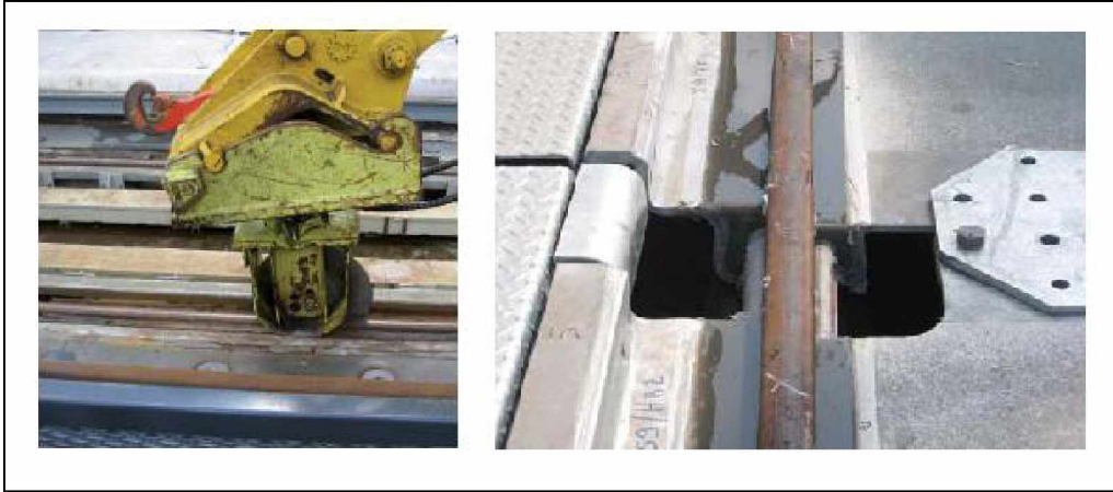
Kuva 5.11 a) Joustomassan leikkaaminen kiskon ympäriltä b) Kouruelementtien liitoskohta ja katkaisutasku, josta kisko on mahdollista katkaista kiskonvaihtotyötä varten. [54] (muokattu)
