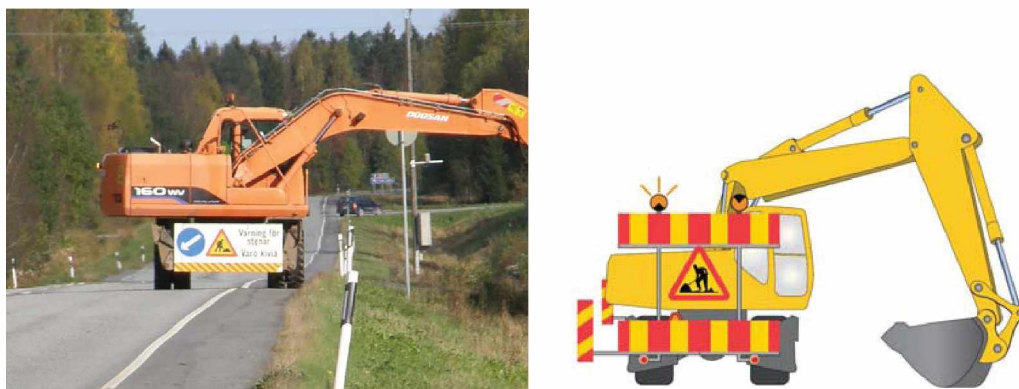
Kuva 21. Tiealueella työskentelevän pyörialustaisen kaivinkoneen ulottuma on suuri. Oikeanpuoleisessa kuvassa esitetty Ruotsin merkitsemistapa auttaisi tienkäyttäjiä hahmottamaan paremmin koneen suurimman ulottuvuuden.
