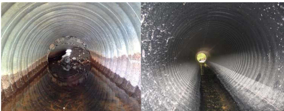
Kuva 36. Rumpujen toimivuus varmistetaan ja kunto inventoidaan urakan aikana.
