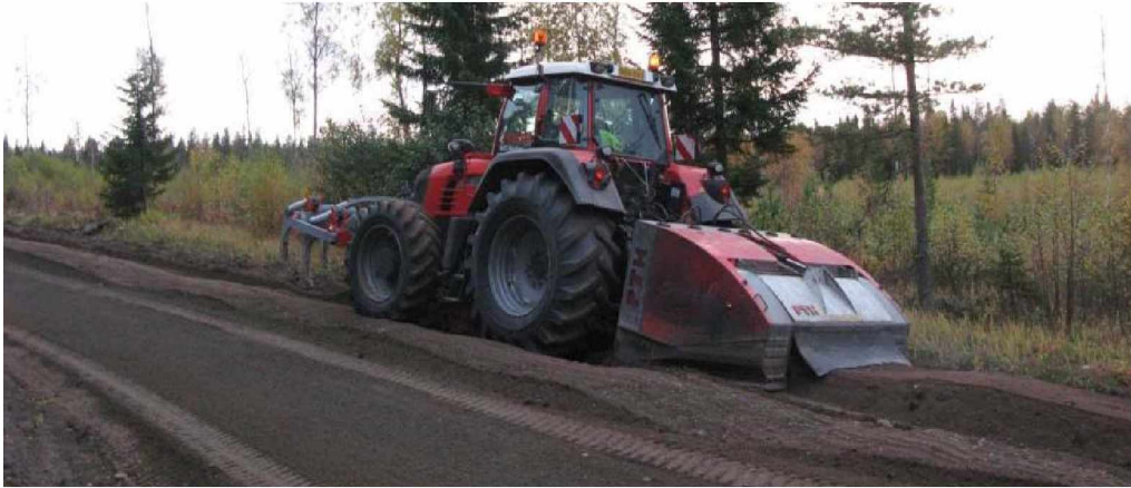
Kuva 41. Tien rungon materiaalin murskausvaihe.
