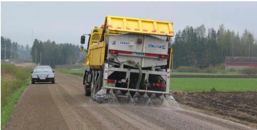
Kuva 29. Soratien pölynsidontaa suolaliuksella.
