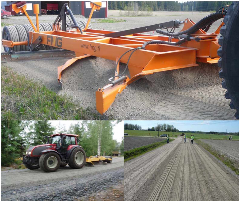
Kuva 26. Soratien muokkausta lanalla, työjälkeä tiivistää kumipyörästö.
