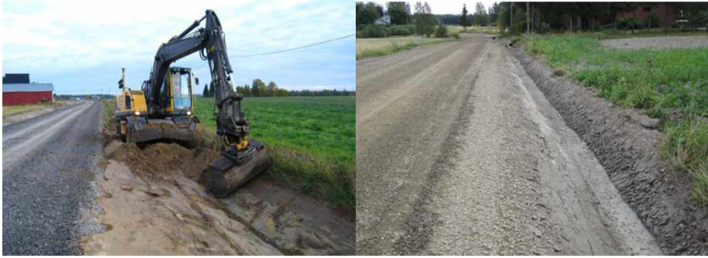
Kuva 32. Sivuojan kunnostusta ja kunnostettu sivuoja.
