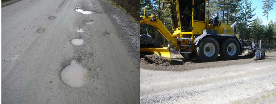
Kuva 31. Nykyaikainen tiehöylä vaativassa tasaustyössä.
