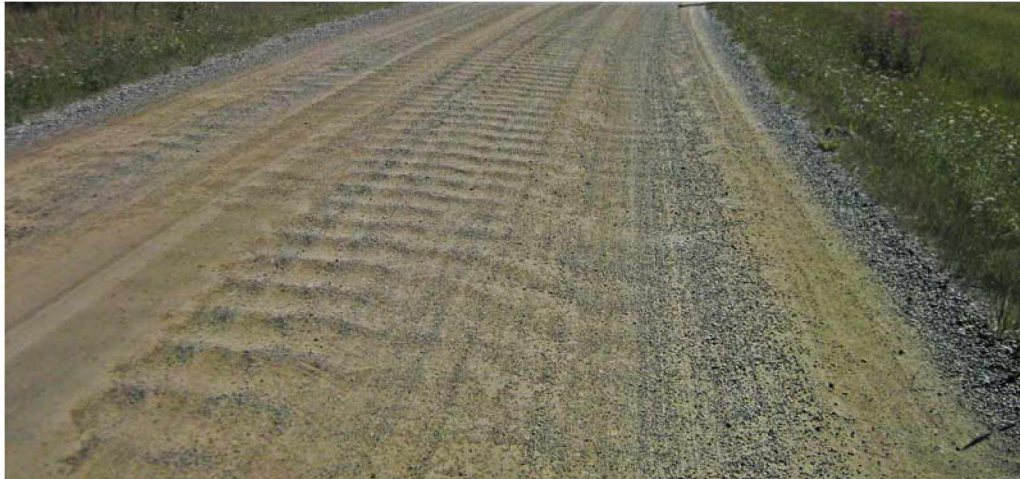
Kuva 9. Aaltomaista ajomukavuuden pilaavaa epätasaisuutta.
