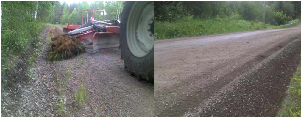
Kuva 34. Reunamateriaalin nostoa tielle lanalla.
