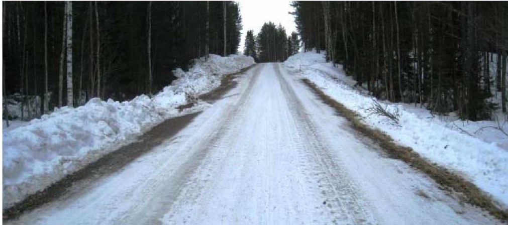
Kuva 20. Hyvin tehdyt sohjo-ojat.
