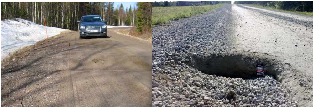
Kuva 6. Rumpuheitto ja rumpun rikkoutumisen aiheuttama reikä.
