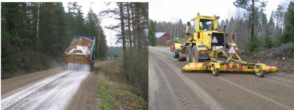
Kuva 28. Suola levitetään ja sekoitetaan, lopuksi pinta tiivistetään.
