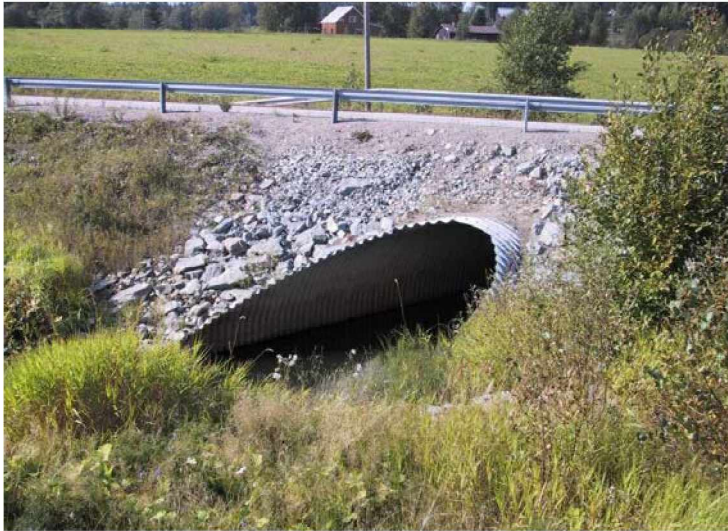
Kuva 54. Avijoen silta Orimattilassa edustaa putkisiltaa vähäisen uoman ylitse. Luokka IV.
