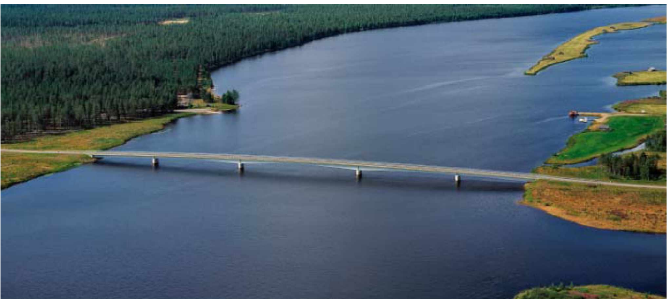
Kuva 11. Suvannon kylä ainoana sodassa säilyneenä tyypillisenä Lapin kylänä luo paikalle merkittävän kulttuuriarvon. Sillan soveltaminen vähäeleisesti kylän reunaan on tässä tapauksessa kulttuuriarvoa kunnioittava ratkaisu. Luokka I.
