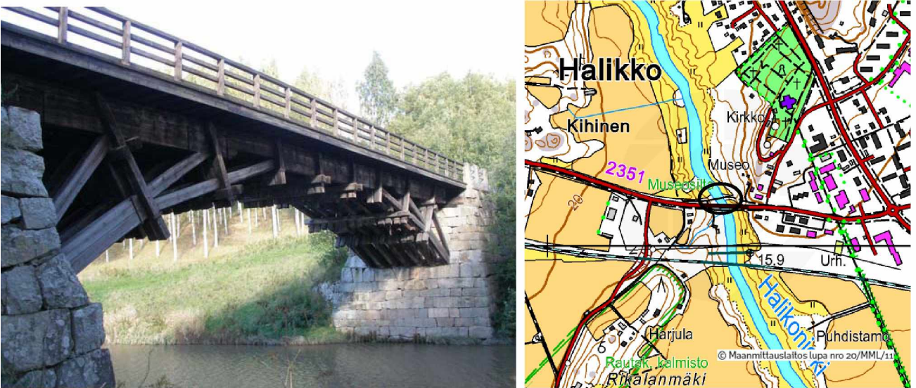
Kuva 13. Halikon siltapaikalla yhtyvät sekä kulttuurimaiseman että rakennusperinnön arvot. Silta on toteutettu vuonna 1864 aikansa rakennustekniikalla ja se kuvastaa hyvin sillan vaikutusta maisemaan menneinä aikoina. Tämä puinen ansassilta on nykyisin museosilta lisäten paikan kulttuuriarvoa omalta osaltaan. Kunnossapito alkuperäisenä on tärkeää. Luokka I.
