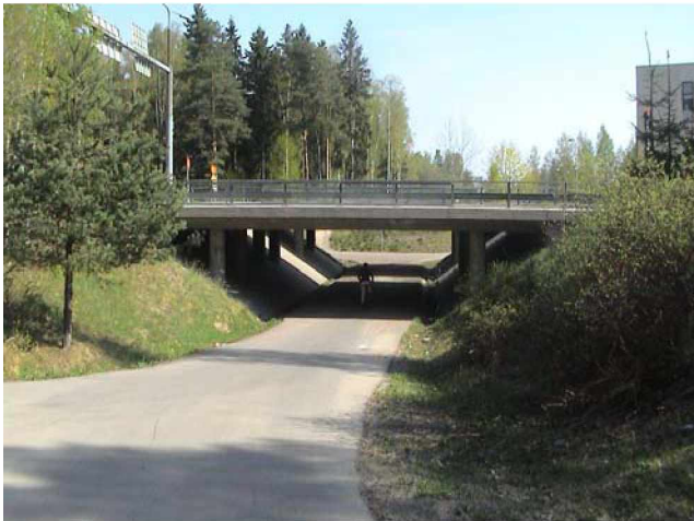
Kuva 24. Rajatorpan alikulkukäytävä Vantaalla on keskeisellä paikalla mahdollistaen kevyenliikenteen valtatiejakaman alueen sisällä turvallisesti. Ulokelaattasilta sopii vilkkaisiin alikulkuihin avarana ratkaisuna. Luokka II.
