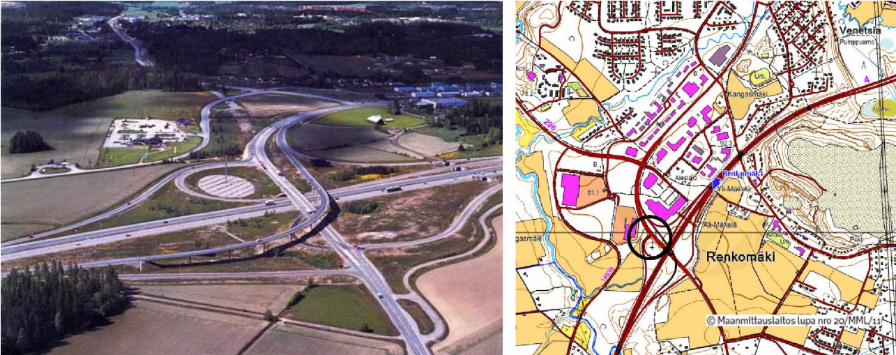
Kuva 18. Renkomäen liittymäalue on tärkeä sisääntulon porttikohta Lahteen moottoritieellä. Liikenneverkollista merkittävyyttä on haluttu korostaa taideaiheella ja sillan rakenteiden muotoilulla ja väreillä, vaikka lähiympäristö muutoin on tavanomainen peltomaisema. Luokka II.
