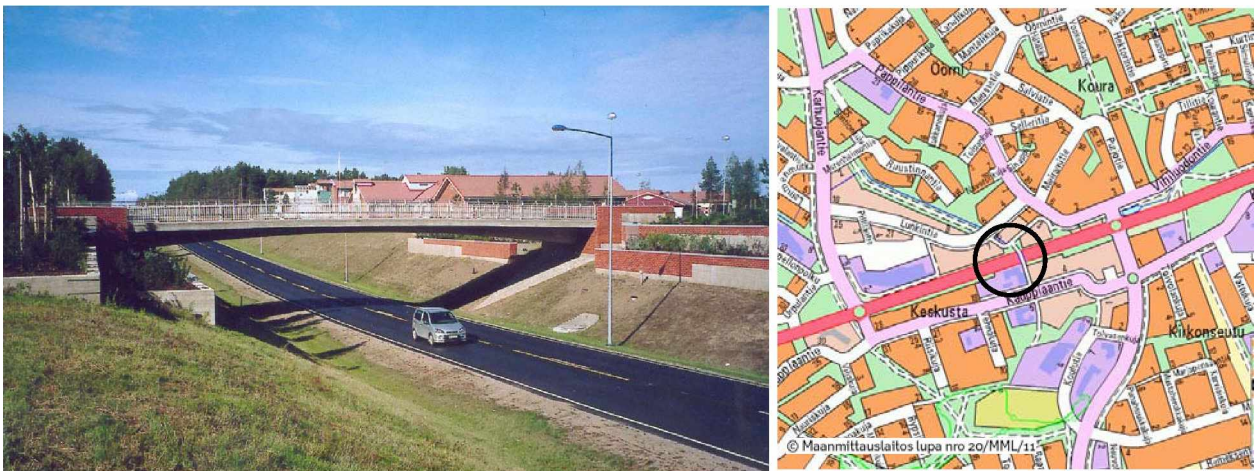
Kuva 5. Kevyen liikenteen silta Oulunsalossa yhdistää keskustan eri osat toisiinsa. Alittavalla lentokentälle johtavalla väylällä liikkuu paljon katsojia. Silta-arkkitehtuuri kuvastaa Oulunsalon tunnettua Oulun koulun kaupunkikuvallista tyyliä. Luokka I.
