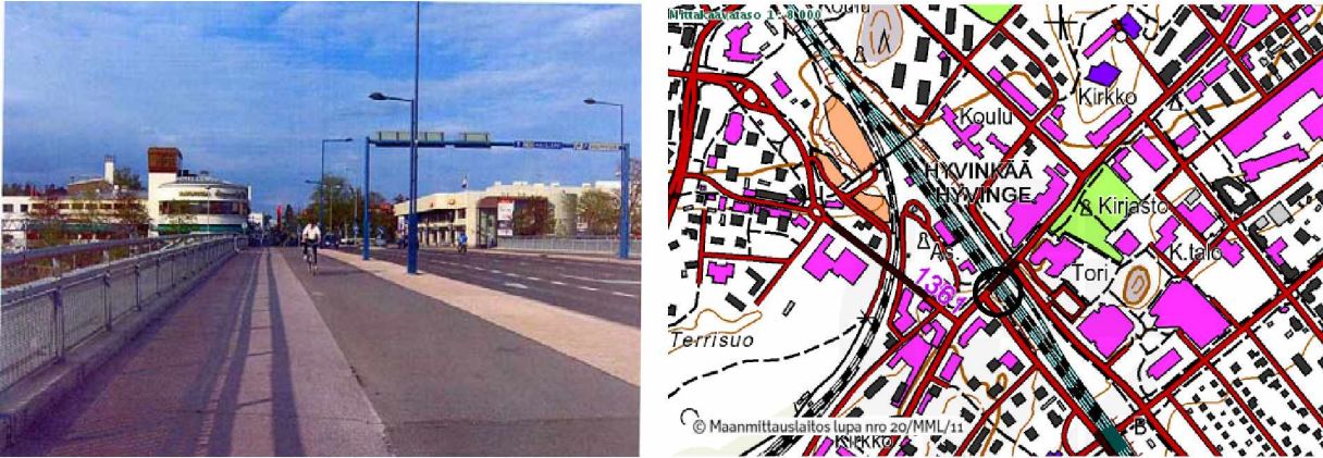
Kuva 26. Hyvinkään ydinkeskustaan, ratapihan päälle sijoittuva Hämeensilta on kaupunkikuvallisesti tärkeä kohokohtainen paikka. Siltaa katsellaan myös alapuolelta sijoittuvalla rautatieasemalta. Peruskorjauksessa on esteettisenä tavoitteena ollut pintojen ja varusteiden kuten kaiteiden ja valaisinten hyvä arkkitehtoninen laatu. Luokka I-II.
