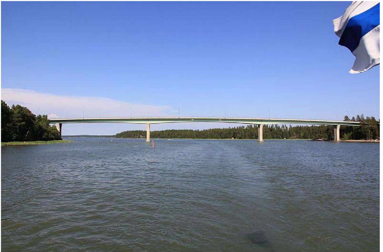
Kuva 31. Kuggsundin silta on arvokkaassa saaristomaisemassa lännestä Porvoon johtavalla vesiväylällä. Se hallitsee suuruutensa vuoksi maisemaa ja tämän vuoksi on tärkeää, että se on muotoiltu ja sovitettu luontevaksi osaksi ympäristöään. Luokka II.
