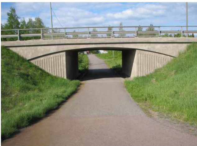
Kuva 25. Koulun alikulkukäytävä Tyrnävällä sijaitsee kirkonkylän keskustassa. Muotoilu ja betonipinnan uritus antavat rakenteelle huolitellun leiman. Värien käyttö esimerkiksi kaiteissa voisi olla paikallaan. Luokka II.
