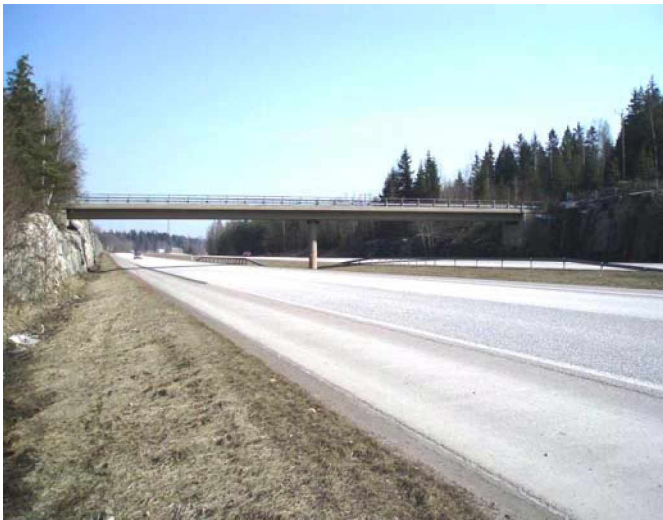
Kuva 40. Höggeretin risteyssilta Porvoossa, Porvoon moottoritien yli, sijoittuu metsätaipaleelle. Koska tie on vilkasliikenteinen, tulee mittasuhteiden olla hyvät, vaikka paikka on III-luokkaa.
