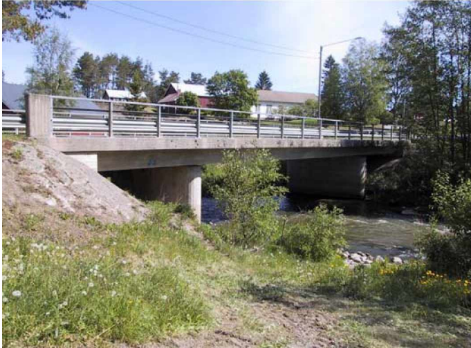
Kuva 36. Irjanteen ulokelaattasilta Eurajoella on vanhassa kylätaajamassa kirkon ja museon vieressä. Se yksinkertaisuudessaan sopii hyvin paikkaansa erottumatta liikaa arvokkaasta kulttuurimaisemasta. Värin käyttö kaiteissa olisi paikallaan. Keilat tulisi verhoilla turvemuurauksella tai siirtonurmella mieluummin kuin betonilaatoilla sillan liittämiseksi lähiympäristöön luontevasti. Luokka II.
