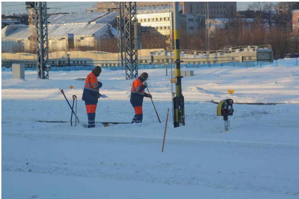
Kuva 6. Vaihteiden puhdistusta Helsingin ratapihalla. (Kuva: Pertti Tapola.)
