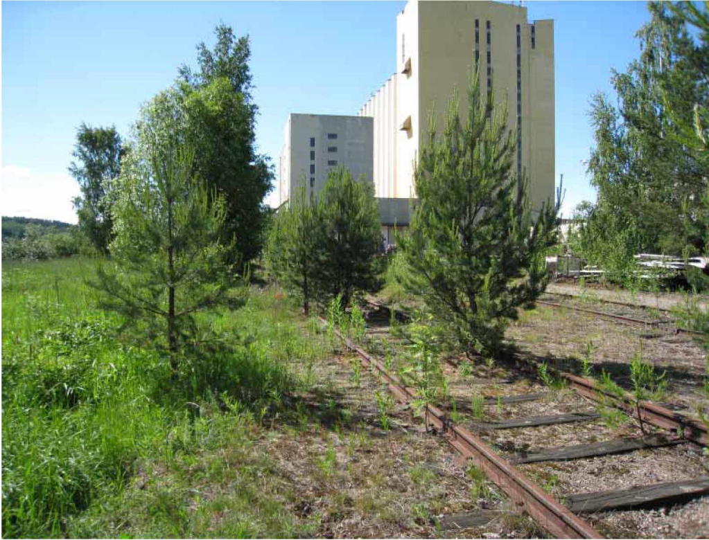
Kuva 6. Koealue kesäkuussa 2009. Koepenger rakennettiin etualalla näkyvän raiteen kohdalle. Viljasiilo näkyy taustalla. Kuva Kauko Sahi.
