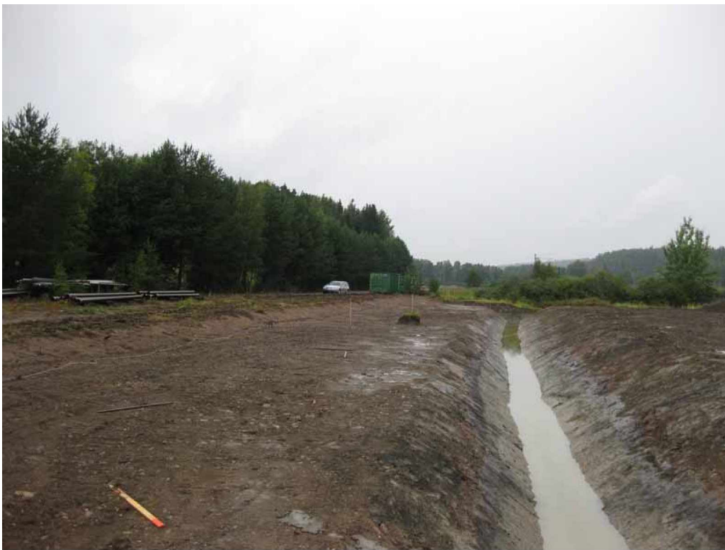
Kuva 35. Koealue pintamaan ja kasvillisuuden poiston ja ojan kaivuun jälkeen siilolta päin kuvattuna. "Ruohotuppo" kuvan keskellä on aiemmin asennettu huokospaineanturi, jonka ympäriltä maata ei ole poistettu. Täytön ja harmaan saven raja näkyy selkeästi ojaluiskassa.
