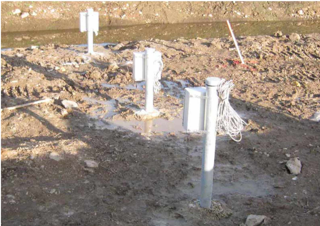
Kuva 37. Juuri asennettuja inklinometriputkia. Kuvassa on näkyvissä varsinaisten inklinometriputkien noin 2 m pitkät suojaputket, joihin on kiinnitetty tallenninyksiköiden laatikot. Inklinometrit ankkuroitiin putkiin hiekalla, jonka tiivistämiseen käytettiin vettä. Kuva Kauko Sahi.
