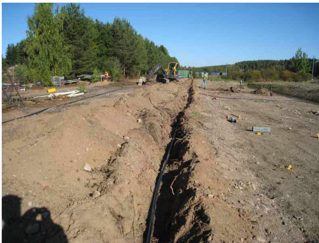
Kuva 36. Painumaletkujen asennusta. Kuva Kauko Sahi.
