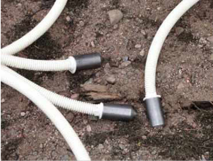
Kuva 26. Liukupintaputkia kärkineen ennen asennusta. Kuva Tim Länsivaara.
