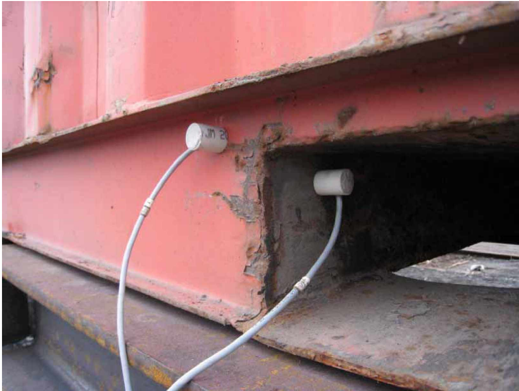
Kuva 30. Kiihtyvyyssantureita konttiin kiinnitettyinä.
