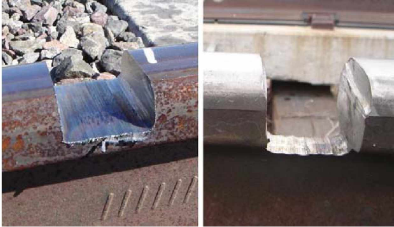
Kuva 63 Hamaran termiittikorjaushitsausta varten valmistetut lovet [88].
