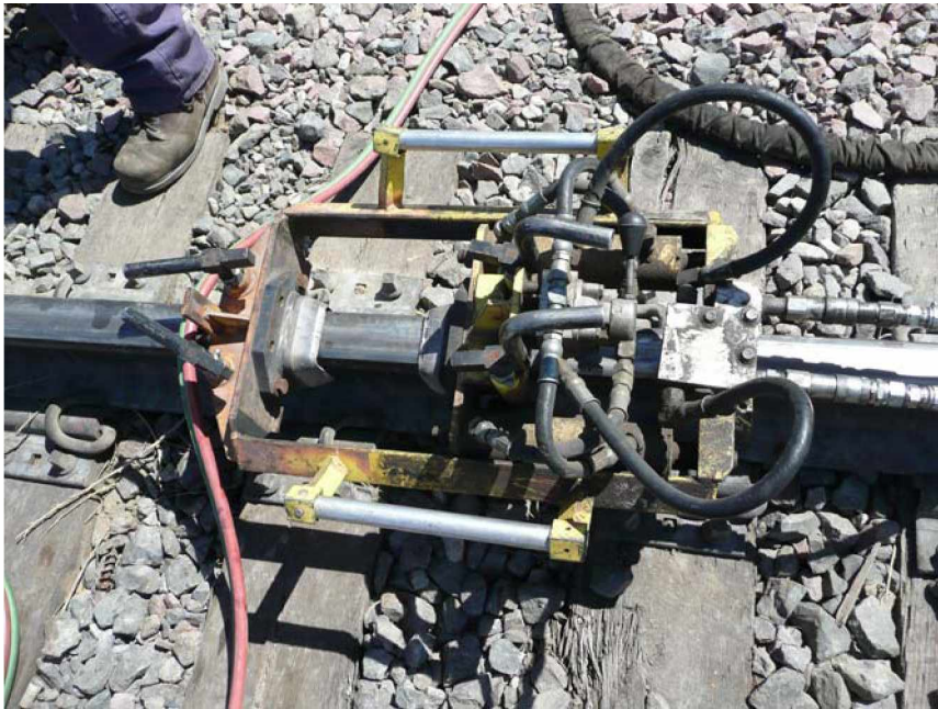
Kuva 16 Hydraulinen kuumatyöstölaite.
