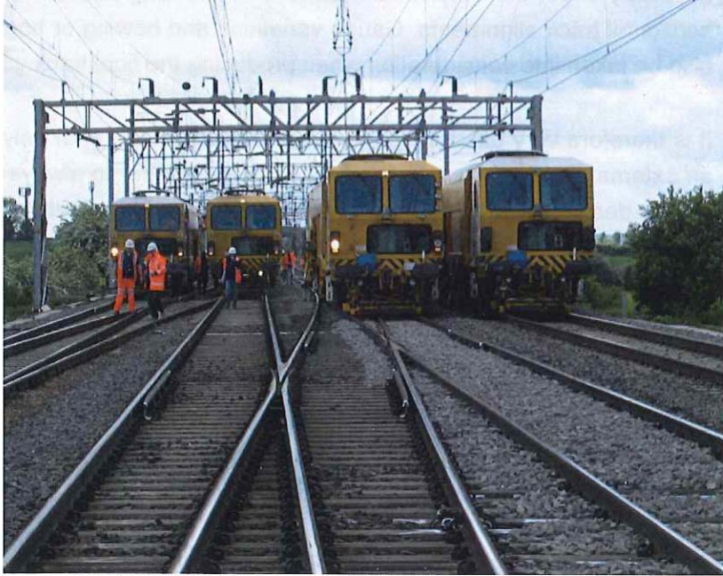
Kuva 4.6. Vierekkäisten vaihteiden tandemtuentaa Isossa-Britanniassa. [45]
