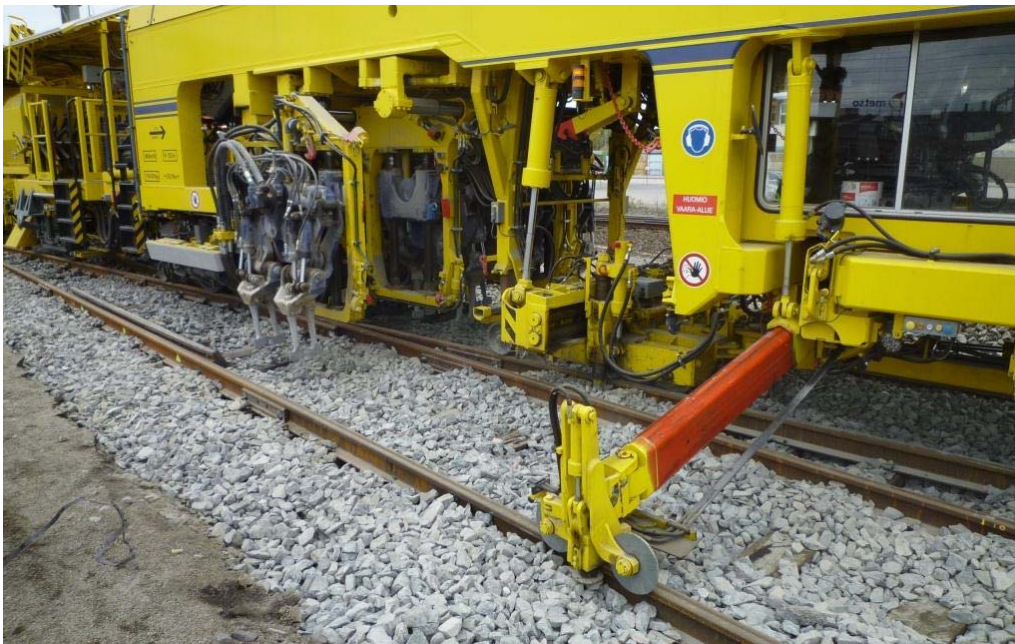
Kuva 5.32. Etualalla vaihteentukemiskoneen nostopuomi poikkeavan kiskon nostamiseen. Taustalla sivusuunnassa siirretyt tukemishakut poikkeavan raiteen tukemiseen vaihteen suoraan raidetta tuettaessa. Työskentelysuunta on kuvassa oikealle.
