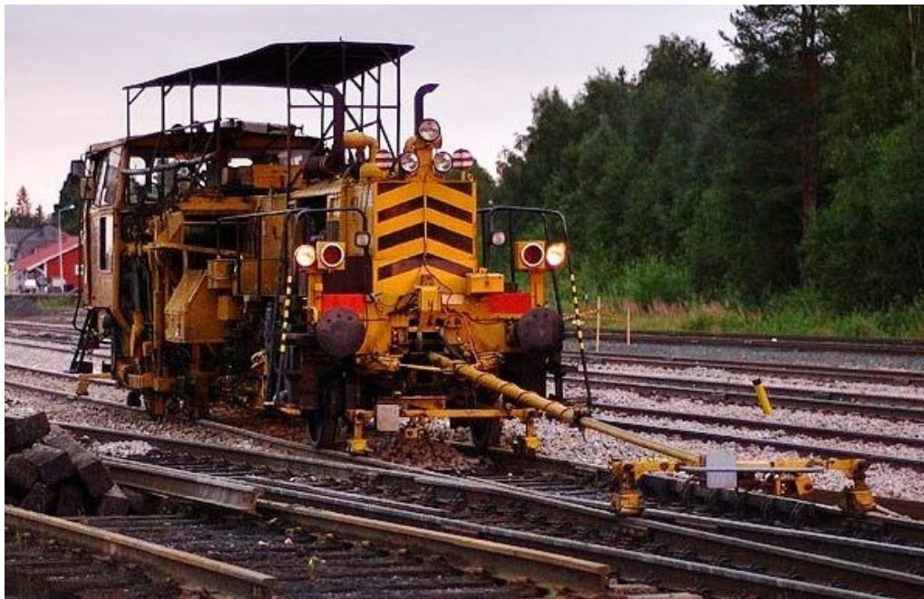
Kuva 5.34. Tukemiskone Matisa B133 työkunnossa Kontiolahden liikennepaikalla. Muokattu lähteestä [28]
