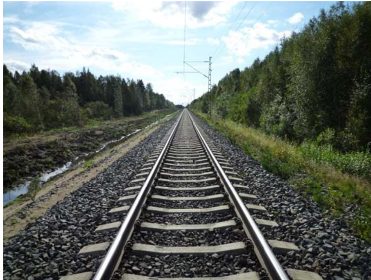
Kuva 6.30. Yleiskuva kohteesta 719+300 etelään Hirvinevan liikennepaikalle päin.
