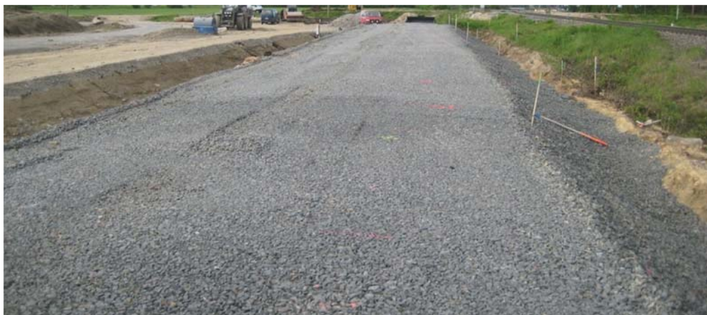
Kuva 2.16. Kalliomurskeesta rakennettu yhdistetty väli- ja eristyskerros tiivistettynä Seinäjoki – Ruha -kaksoisraidetyömaalla.
