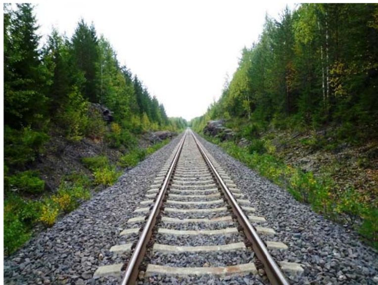
Kuva 6.12. Yleiskuva kohteesta itään Heinäveden liikennepaikalle päin.
