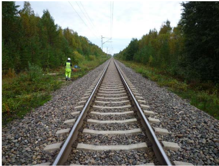
Kuva 6.26. Yleiskuva kohteesta 687+400 pohjoiseen Tuomiojan liikennepaikalle päin.
