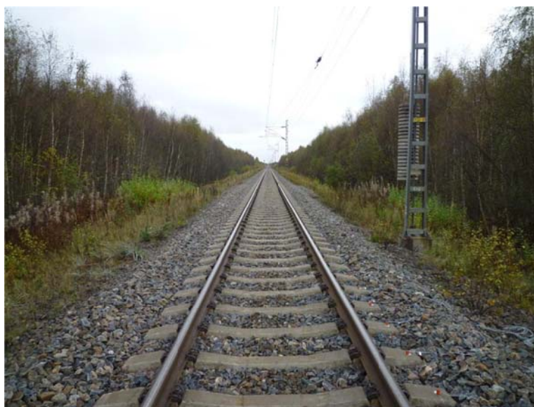
Kuva 6.18. Yleiskuva kohteesta etelään Limingan liikennepaikalle päin.
