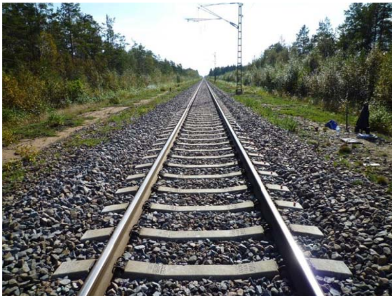
Kuva 6.27. Yleiskuva kohteesta 689+700 etelään Vihannin liikennepaikalle päin.
