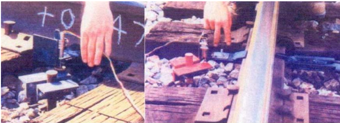
Kuva 4.29. Siirtymäanturimittauksessa käytetyn referenssitangon pää ja siirtymäanturi (vas.) sekä anturin kiinnitys kiskon jalkaan (oik.). Muokattu lähteestä [84]
