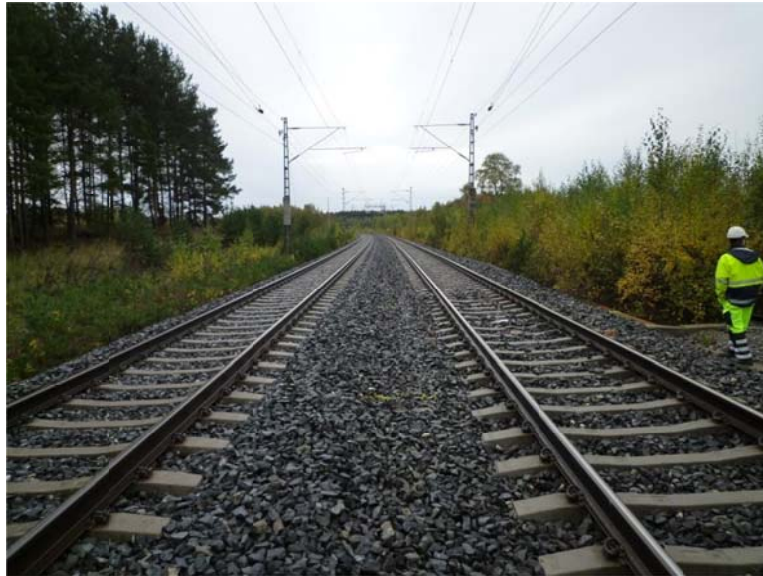
Kuva 6.22. Yleiskuva kohteesta Viialan liikennepaikalle päin.
