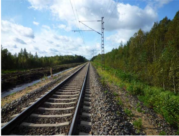
Kuva 6.29. Yleiskuva kohteesta 718+420 etelään Hirvinevan liikennepaikalle päin.
