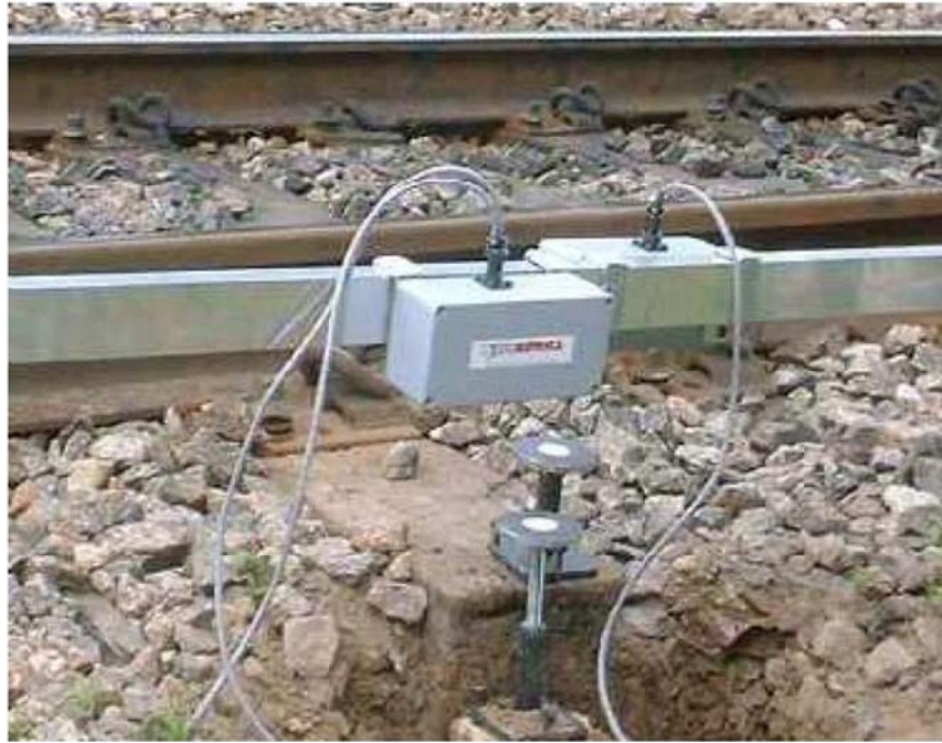
Kuva 4.18. Laserlähteet kehikossa sekä heijastimet asennettuna ratapölkyn päähän ja tukikerroksen pinnalle. [75]
