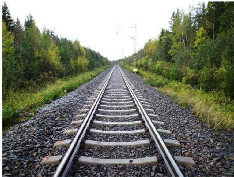
Kuva 6.16. Yleiskuva kohteesta Oulaisen liikennepaikalle päin.
