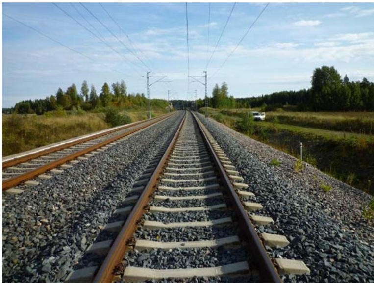
Kuva 6.8. Yleiskuva kohteesta koilliseen Sipilän liikennepaikalle päin.
