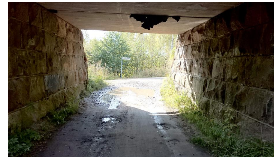
Kuva 27. Tyynelän alikulku puretaan.
