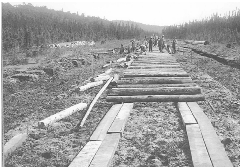
Kuva 34. Puuarinan rakentamista turvepohjamaalle (Hendry 2011).
