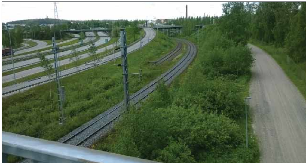
Kuva 31. Kuvassa on Jyväskylän liikennepaikan sivuraiteen 043 päätöskohta ja Jyväskylä–Vaajakoski-suunnitteluosuuden aloituskohta. Vasemmalla moottoritie.
