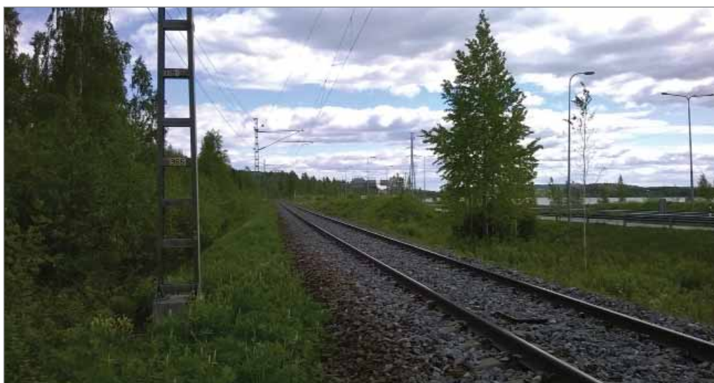
Kuva 32. Näkymä idän suuntaan noin km:n 379+000 kohdalta. Meluvalli sijaitsee nykyisin radan ja moottoritien välissä. Taustalla moottoritien takana näkyy Jyväsjärvi.
