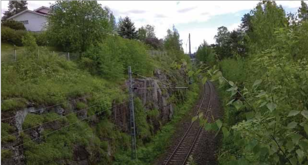
Kuva 33. Näkymä Aittokallion ylikäytäväsilalta idän suuntaan. Rata leikkautuu kallioon kmv:llä 379+850–380+100. Radan vasemmalla puolella kallion päällä on pientaloasutusta. Radan oikealla puolella on radan ja moottoritien välinen suojaviheralue.
