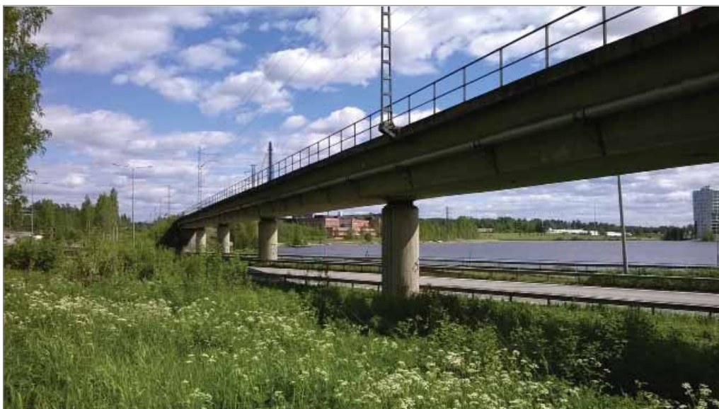
Kuva 34. Näkymä radan vasemmalta puolelta idän suuntaan. Rata ylittää vinossa kulmassa moottoritien Halssilan alikulkusillalla. Taustalla kuvassa näkyy Jyväsjärvi.
