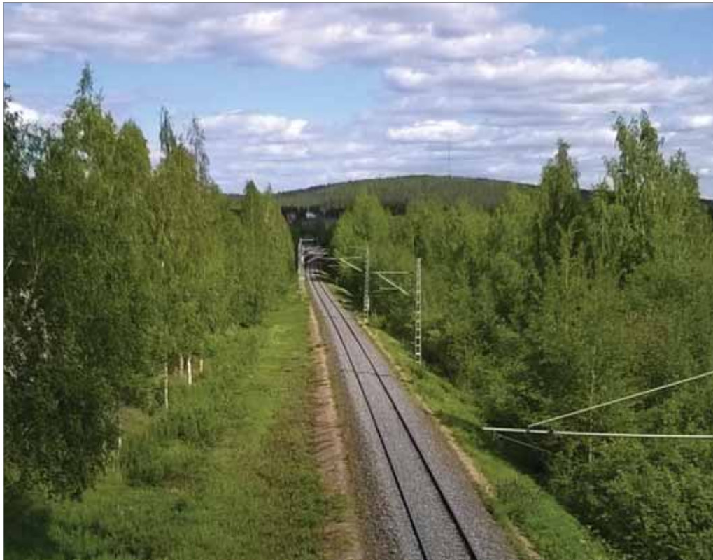
Kuva 38. Näkymä km:n 382+844 Järvelän ylikulkukäytävältä itään päin. Radan S-kaarre oikaistaan suoraksi lisäraiteen puolenvaihdossa. Nykyisten sähköratapylväiden sijoittelu sopii yhteen puolenvaihtokohdan kanssa.
