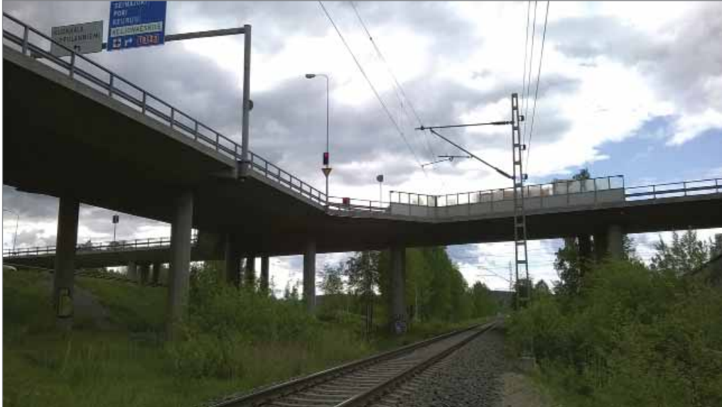
Kuva 20. Näkymä etelän suuntaan, Ristonmaan risteys- ja ylikulkusilta.
