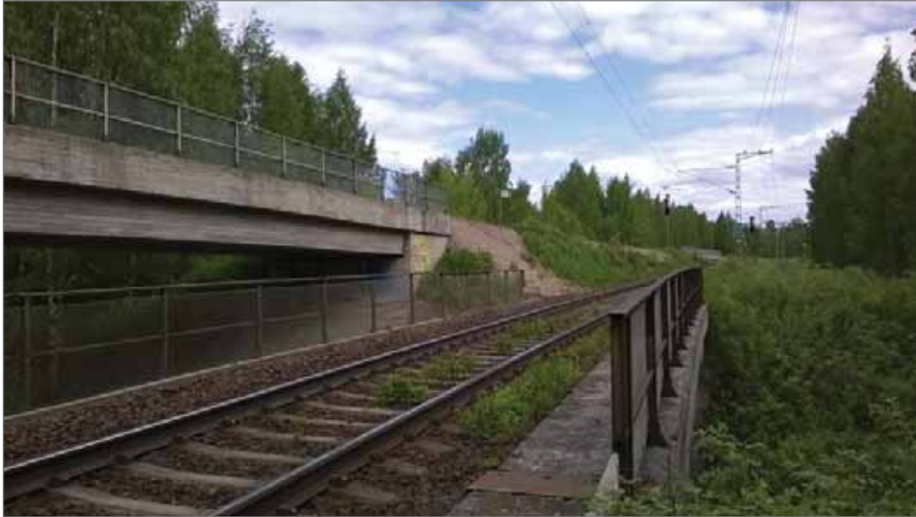
Kuva 26. Näkymä radan oikealta puolelta pohjoisen suuntaan, alemmalla Lemmensilta II:llä Tampere–Jyväskylä-rata, edessä ylempällä Lemmensilta I:lla rata Haapamäen suuntaan.
