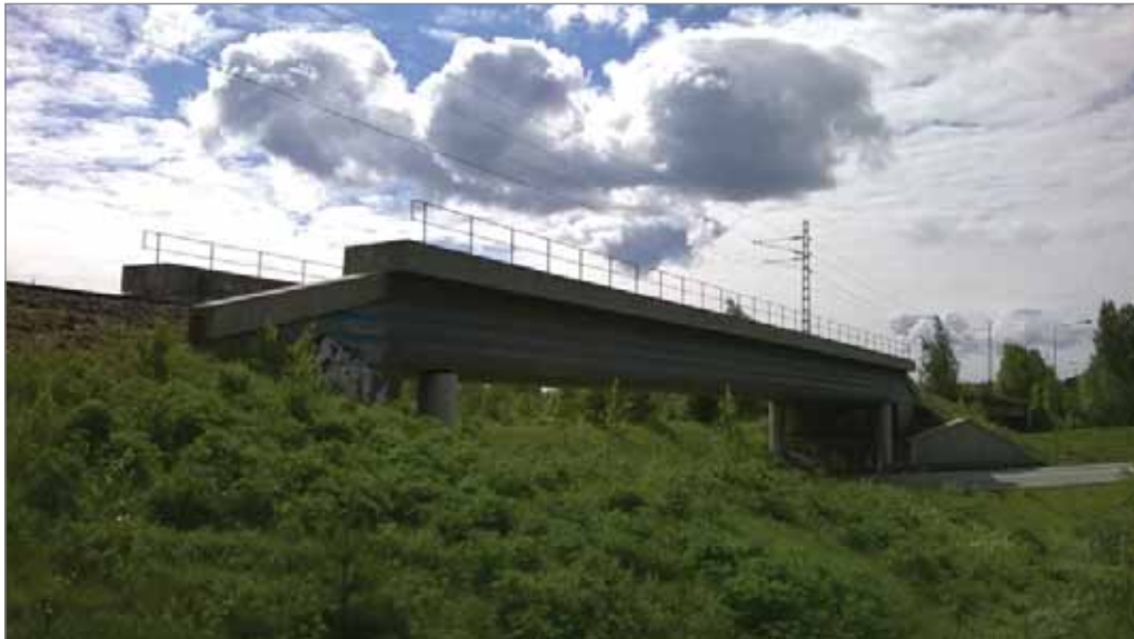
Kuva 19. Näkymä etelän suuntaan, kuvassa edessä Tervalan alikulkusilta II, takana Tervalan alikulkusilta I.
