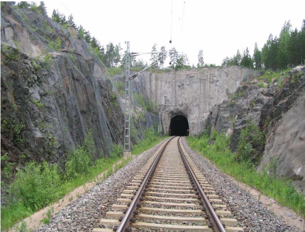
Kuva 42. Valokuva Haukkamäen tunnelin 1. suuaukon kallioleikkauksesta.
