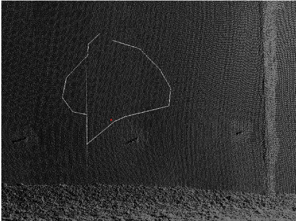
Kuva 19. Intensiteettikuva pullistumasta. Valkoisella viivalla kuvattu pullistuman rajaus. Kuvassa näkyy vaaleana viivana myös rikkoutunut sauma
