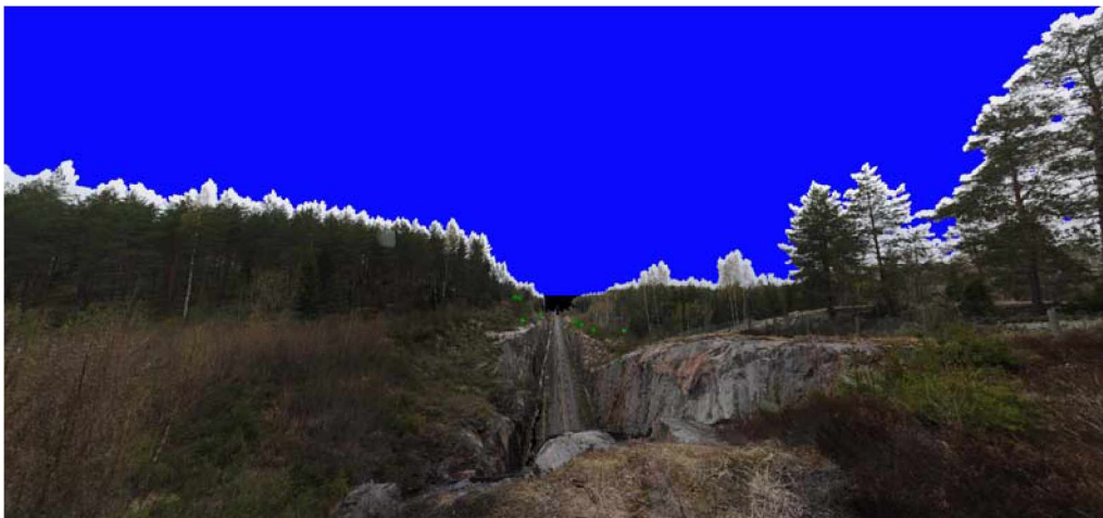
Kuva 35. Pistepilviaineistosta muodostettu kuva Åminnen tunnelin 2. suuaukon kallioleikkauksesta. Näkymä on tunnelin otsapinnan päältä Turkuun päin.
