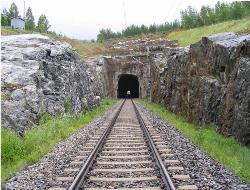
Kuva 51. Valokuva Pepallonmäen tunnelin 2. suuaukon kallioleikkauksesta.
