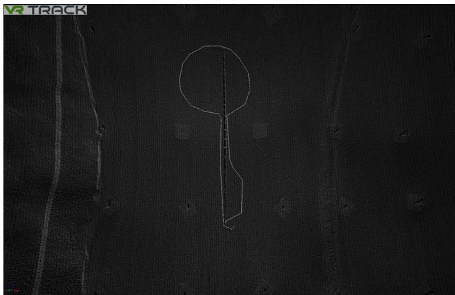
Kuva 23. Intensiteettikuva pullistumasta. Valkoisella viivalla kuvattu pullistuman rajaus. Kuvassa näkyy selkeästi myös rikkoutunut sauma.
