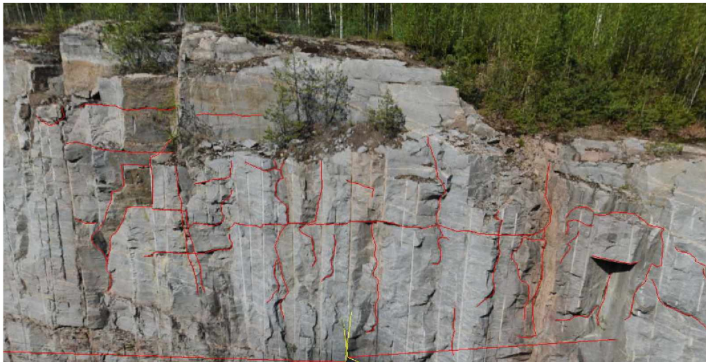
Kuva 61. Pistepilviaineistosta muodostettu kuva Pepallonmäen tunnelin yläreunasta ja siitä digitoituja kallioleikkauksen rakenteita.
