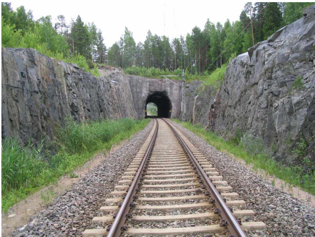
Kuva 40. Valokuva Kaivosmäen tunnelin 2. suuaukon kallioleikkauksesta.
