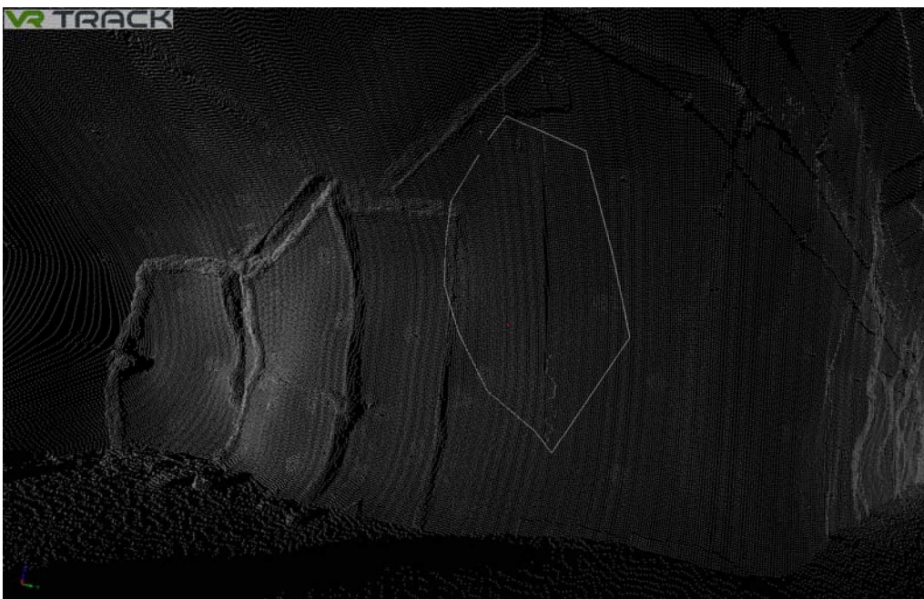
Kuva 21. Intensiteettikuva pullistumasta. Valkoisella viivalla kuvattu pullistuman rajaus. Kuvassa näkyy selkeästi myös rikkoutunut sauma.
