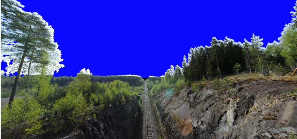
Kuva 38. Pistepilviaineistosta muodostettu kuva Kaivosmäen tunnelin 1. suuaukon kallioleikkauksesta. Näkymä on tunnelin otsapinnan päältä Helsinkiin päin.
