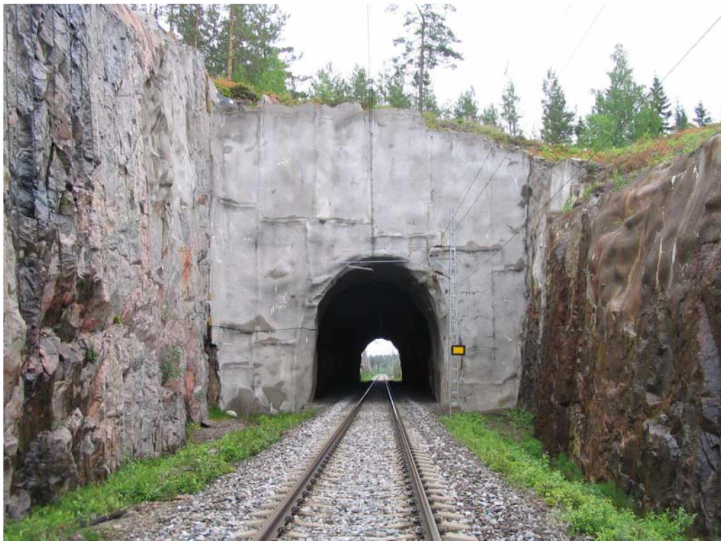
Kuva 34. Valokuva Åminnen tunnelin 2. suuaukon kallioleikkauksesta.
