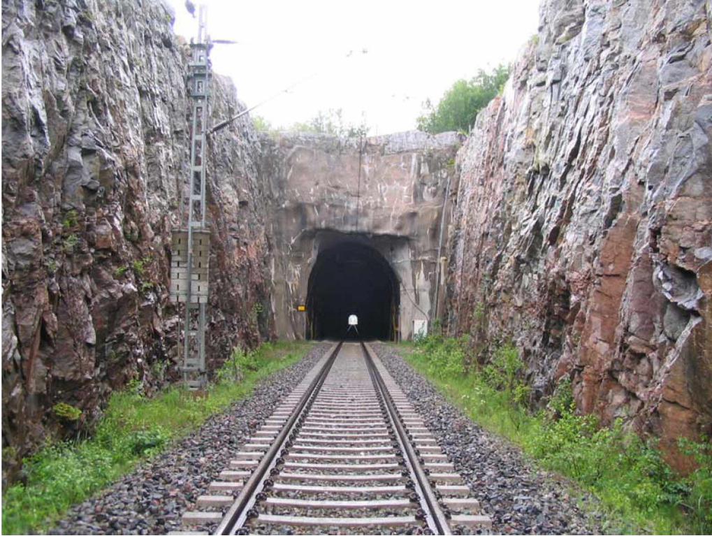
Kuva 47. Valokuva Pepallonmäen tunnelin 1. suuaukon kallioleikkauksesta
