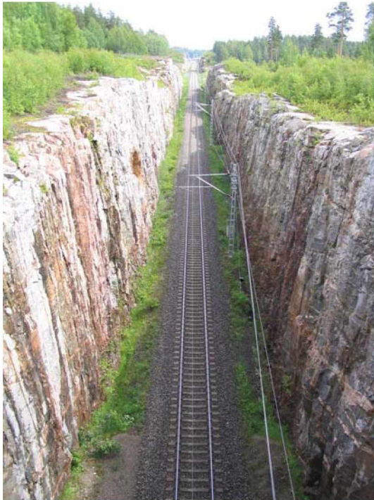
Kuva 49. Valokuva Pepallonmäen tunnelin 1. suuaukon kallioleikkauksesta. Näkymä on tunnelin otsapinnan päältä Helsinkiin päin.
