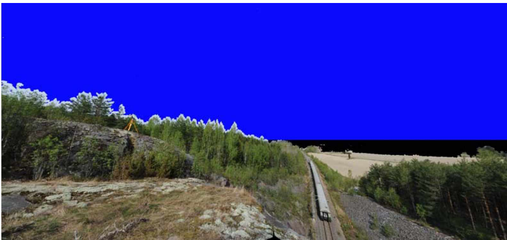
Kuva 45. Pistepilviaineistosta muodostettu kuva Harmaamäen tunnelin 2. suuaukon kallioleikkauksesta. Näkymä on tunnelin otsapinnan päältä Turkuun päin.
