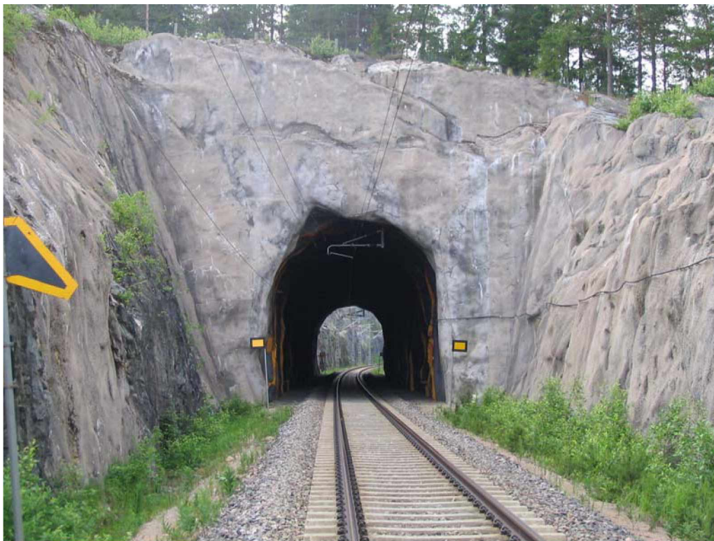
Kuva 37. Valokuva Kaivosmäen tunnelin 1. suuaukon kallioleikkauksesta.
