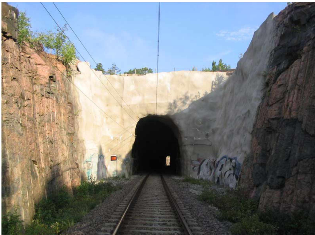
Kuva 31. Valokuva Lillgårdin tunnelin 1. suuaukon kallioleikkauksesta.
