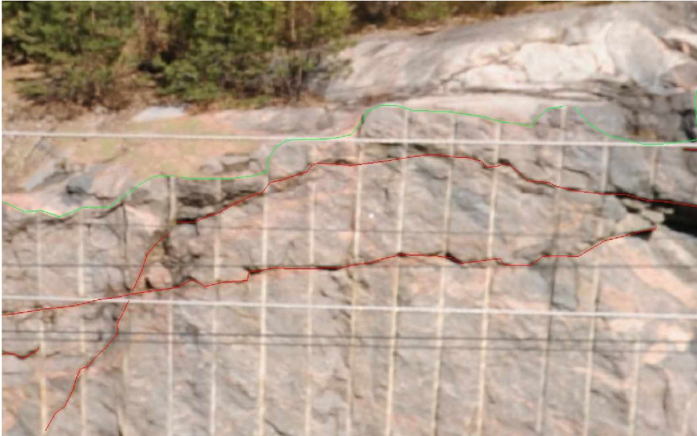
Kuva 62. Kuvassa kallioleikkauksen leikkauksen yläreuna vihreällä ja halkeamat punaisella.
