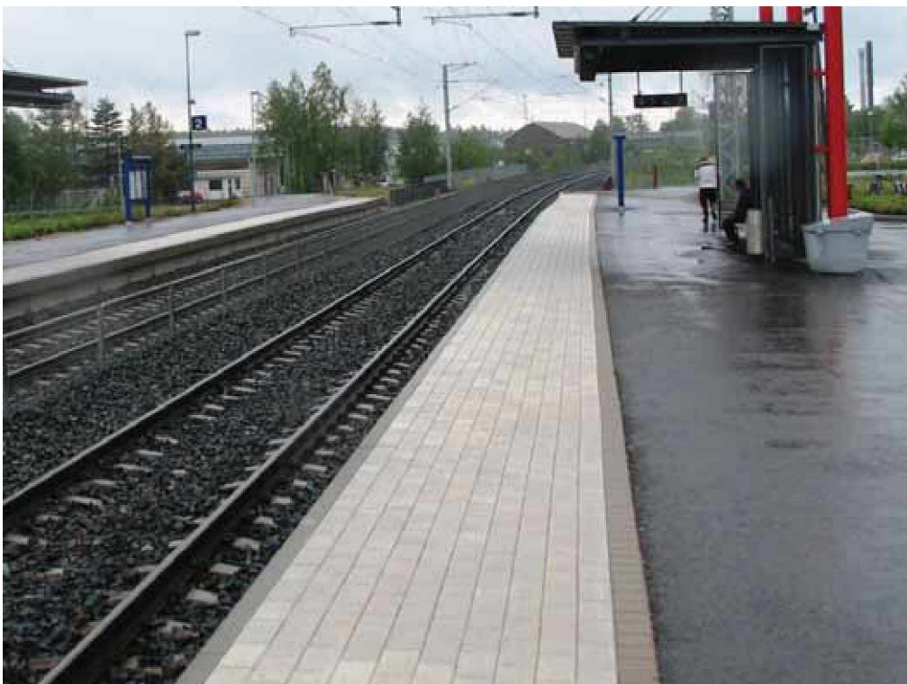
Kuva 17. 550 mm korkea reunalaituri (kuva Masala). Laiturin vaara-alue on merkitty värierolla ja tuntuun perustuvalla merkinnällä. Kuvan laiturilta puuttuu RATO:n mukainen keltainen varoitusviiva vaara-alueen reunalta.
