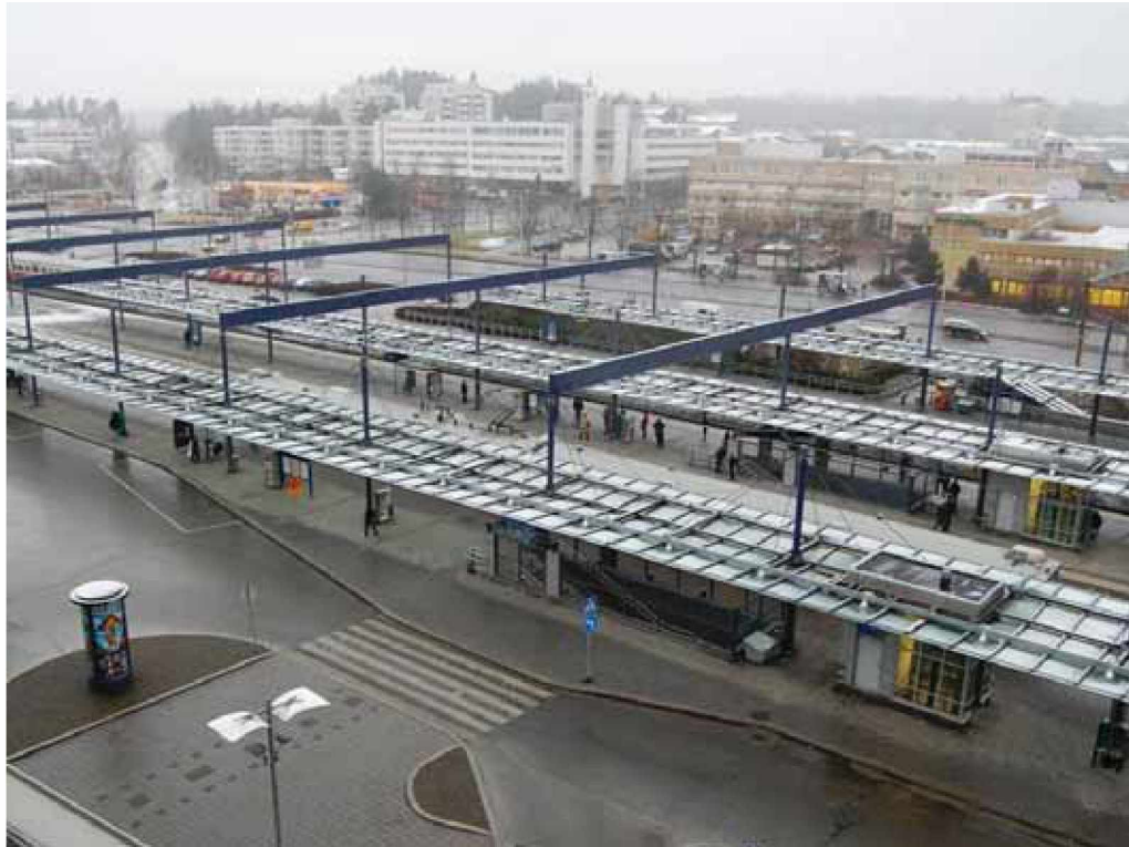
Kuva 19. Laiturikatoksen tulisi kattaa valtaosa asemalle pysähtyneen junan pituudesta kauko ja lähi 1 -luokissa. (kuva Leppävaara).
