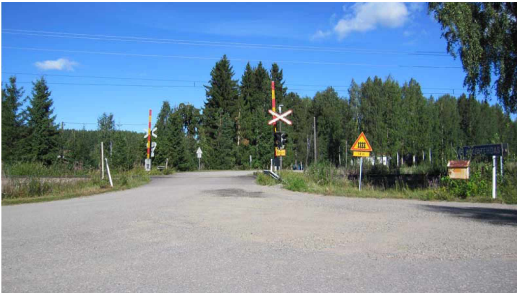
Kuva 5. Huopatehtaan tasoristeys etelästä kuvattuna
