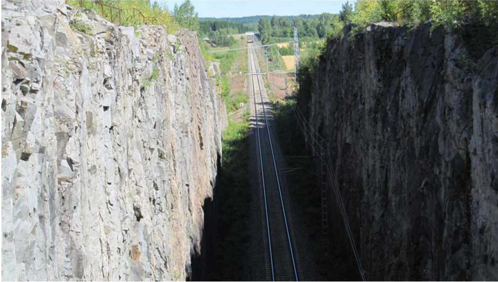
Kuva 8. Kallioleikkaus Kinnarniemen tasoristeyksen eteläpuolella, taustalla, kuvan yläreunassa radan ylittävä Kinnarsalmen ylikulkusilta, km 400+053
