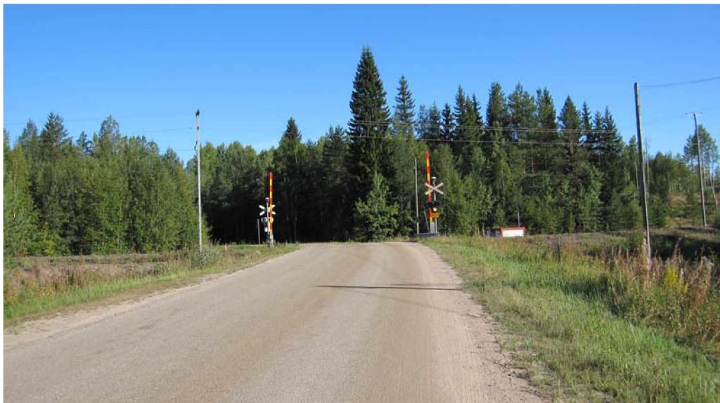
Kuva 1. Heinän tasoristeys idästä kuvattuna
