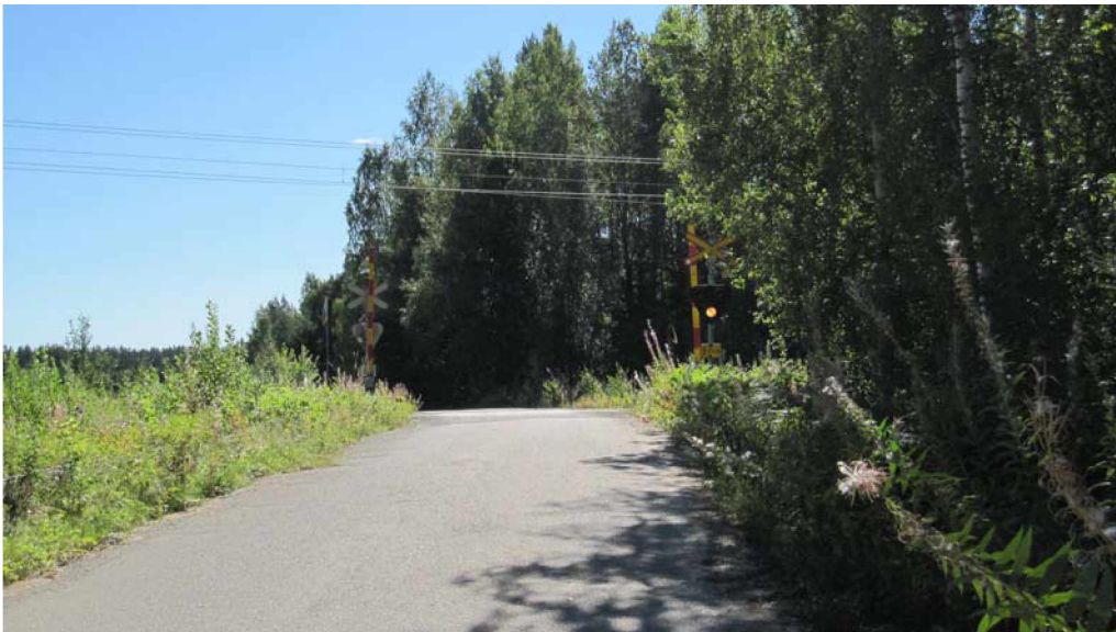
Kuva 9. Honkasennurkan tasoristeys lännestä kuvattuna
