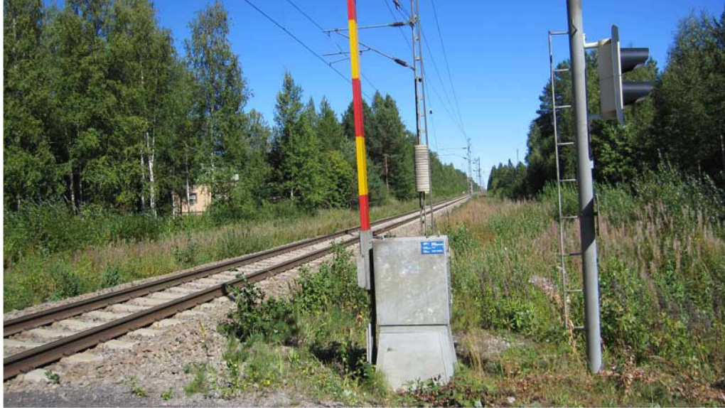
Kuva 10. Pysyvä asusta kymmenien metrien päässä tasoristeuksen Saari (Kuormaustie) tasoristeuksen pohjoispuolella
