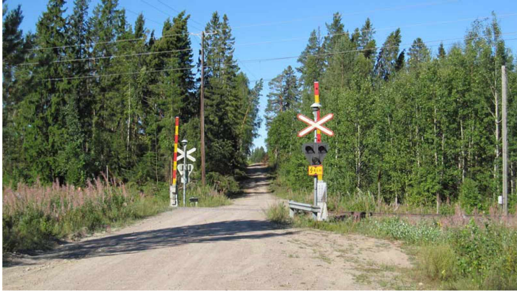
Kuva 3. Punasvaaran tasoristeys idästä kuvattuna
