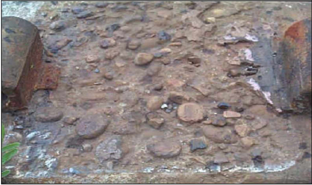
Kuva 25. Sementtipasta on kulunut pois jättäen jäljelle kovemman runkoaineen [82].
